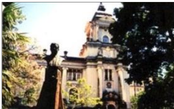
Figura 59: MARGS, após tombamento e antes das obras de reabilitação – vista da Praça da Alfândega. Fonte: http://www.sinpro-rs.org.br/extra/mar98/cultu2.htm (2008).
