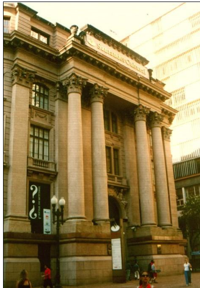
Figura 36: Fachada principal do edifício do Santander Cultural (2008).
