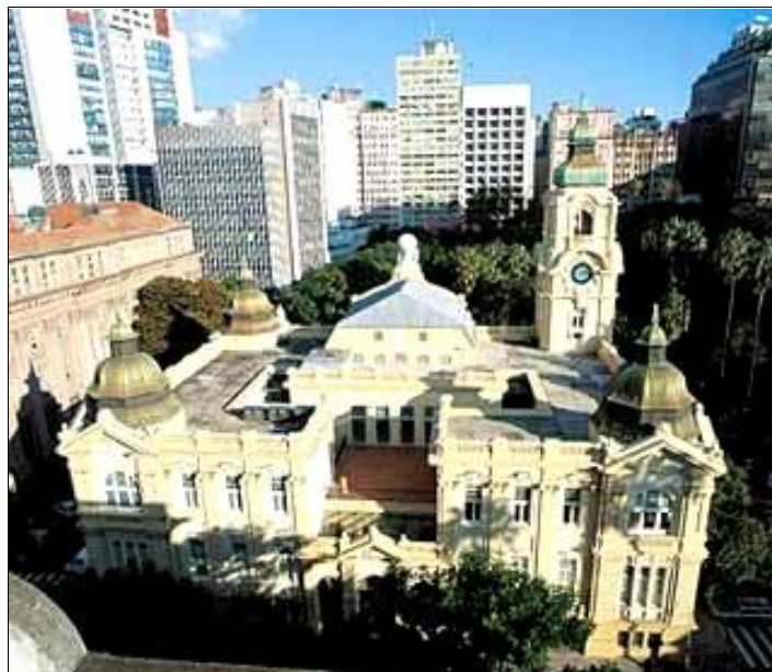
Figura 60: Memorial do RS e ao fundo Praça da Alfândega – vista aérea sul. Fonte: http://www.memorial.rs.gov.br (Acesso em 20/10/2008).
