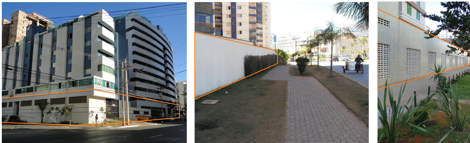
Figura 28 – Exemplos de edifícios com o térreo murado, sem a implantação de uso misto, junho de 2010. Foto da autora.
