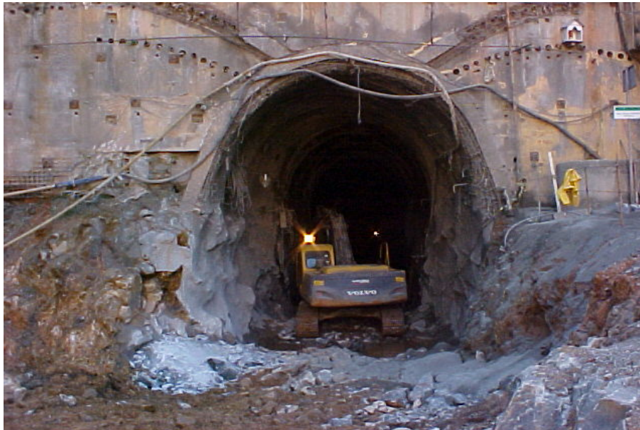
Figura 3.20 – Rebaixo do túnel piloto.
