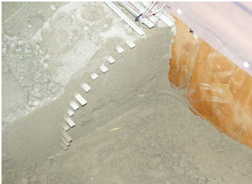
Figura 8.25 – Colocação das enfilagens
