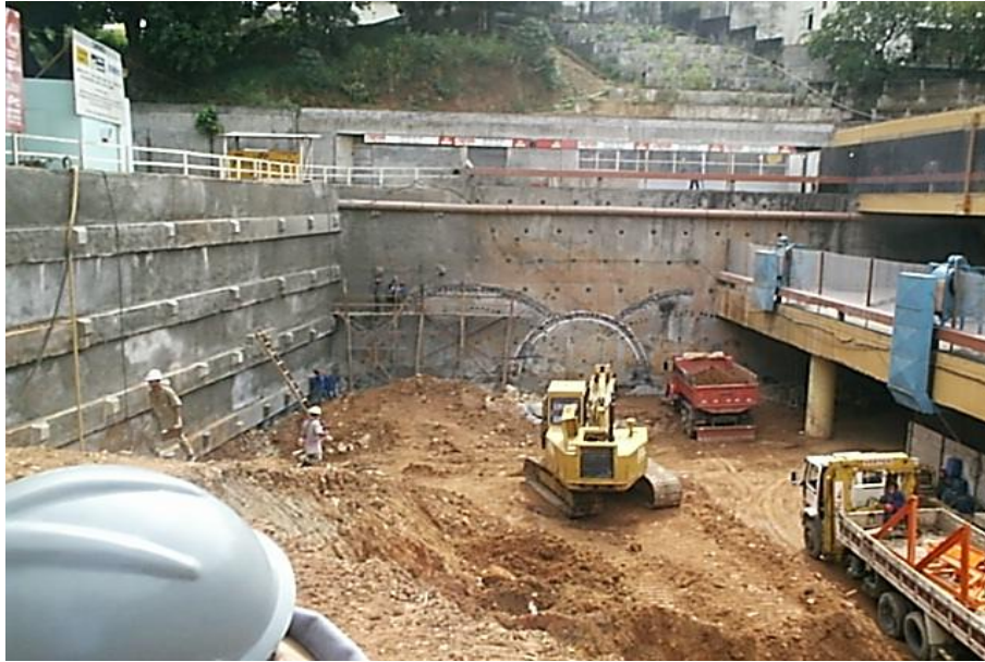
Figura 3.18 - Execução das enfilagens e pregagens no túnel piloto e nos túneis 1 e 2
