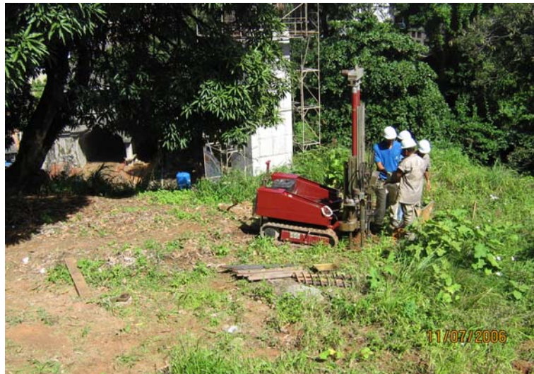
Figura 4.6 – Ensaio de CPT realizado ao topo do túnel
