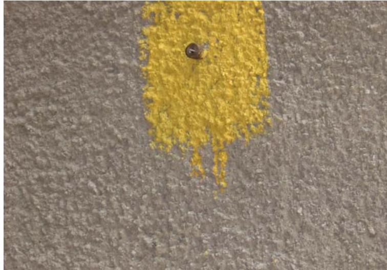
Figura 7.6 - Pino interno de convergência na seção E-0+507,20 m
