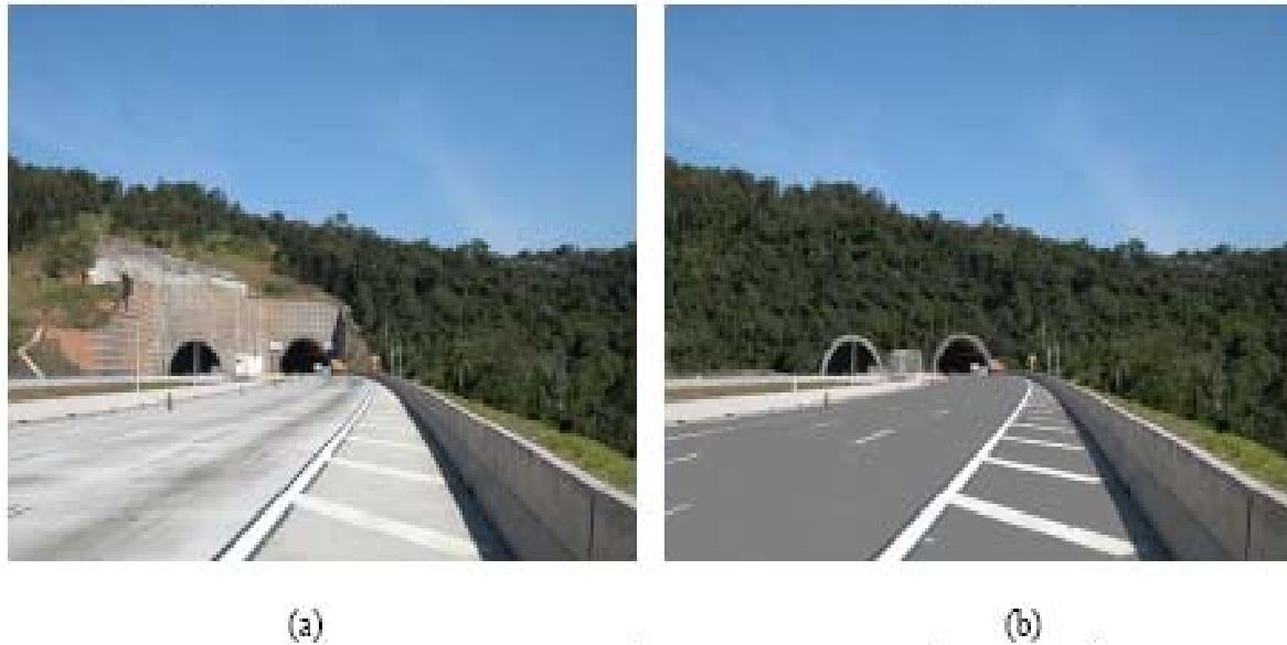
Figura 2. 2 - Emboque Gramado (TE-3). (a) Situação existente. (b) Aplicação das estratégias, alterando a refletância da pista de 30% para 15% (estratégia 1) e substituindo o entorno do portal (estratégia 2) (Moura, 2006).
