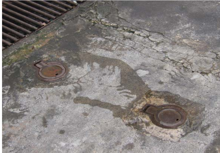
Figura 7.4 - Tassômetro e marco superficial instalados na seção do emboque (E-0+504,66 m)
