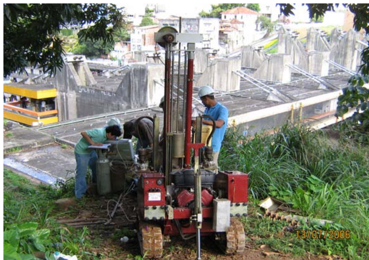
Figura 4.16 – Ensaio de DMT realizado ao topo do túnel
