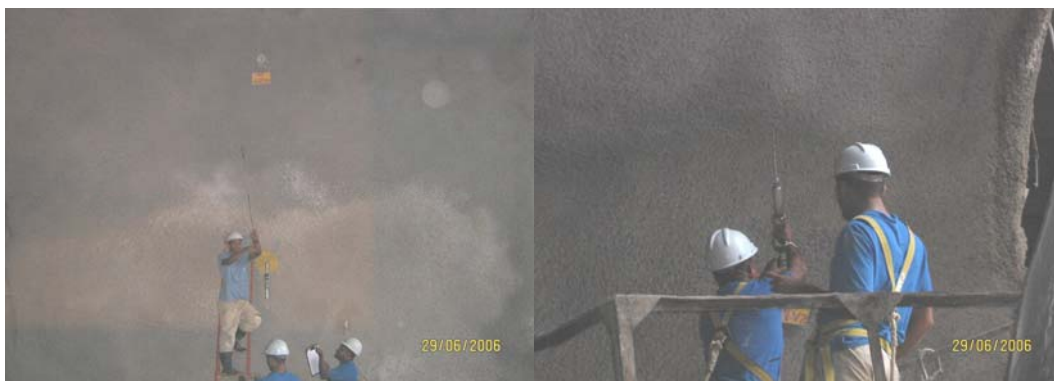
Figura 7.20 – Leitura da instrumentação interna
