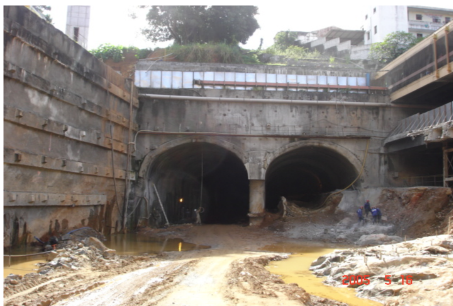
Figura 3.26 – Via 2: continuação dos trabalhos com avanços de 1, 5 a 4,0 m. Execução do concreto projetado e chumbadores laterais a cada avanço
