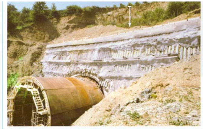
Figura 2.11 – Utilização de estacas de pequeno diâmetro e tirantes protendidos (modificado - Lunardi, 2006)
