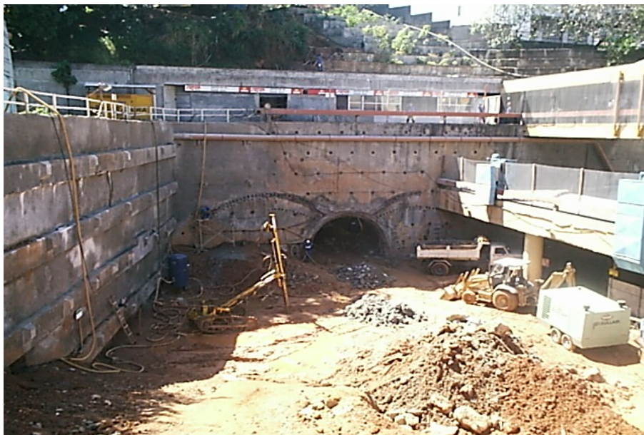
Figura 3.19 - Instalação da tela no trecho escavado do túnel piloto. Instalação da 1ª cambota e execução do concreto projetado
