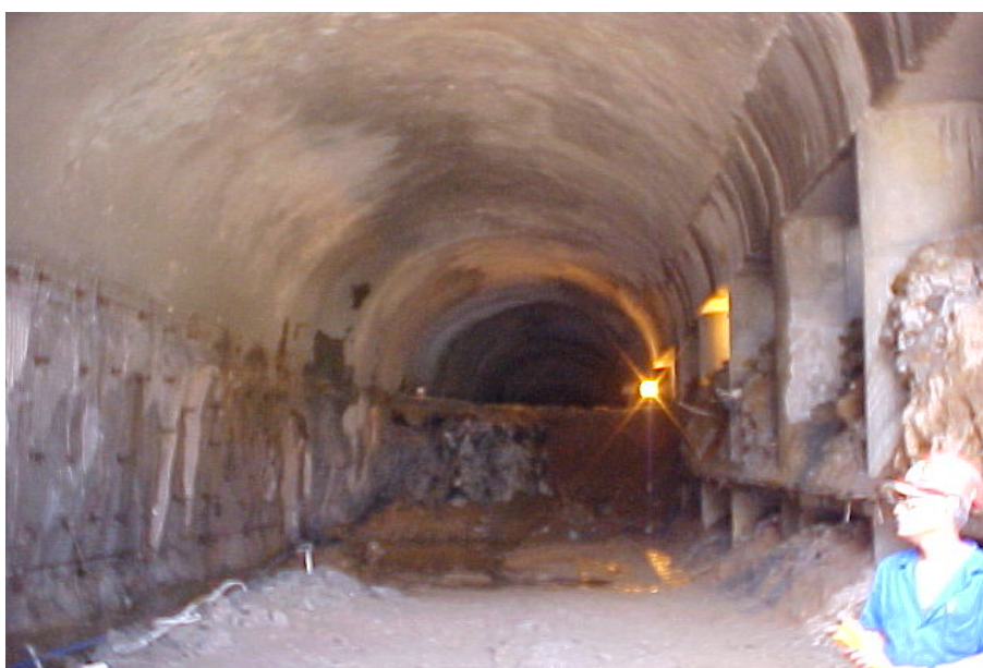
Figura 3.25 – Via 1: continuação dos trabalhos com avanços de 1,5 a 4,0 m. Execução do concreto projetado e chumbadores laterais a cada avanço
