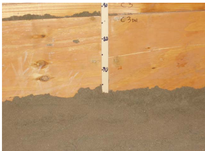
Figura 8.24 – Lançamento da areia siltosa.
