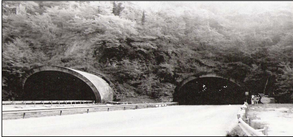
Figura 2.7 - Portal com “bico de flauta invertido”. A8, autoestrada Ventimiglia-Nizza – França (Langella, 1997).
