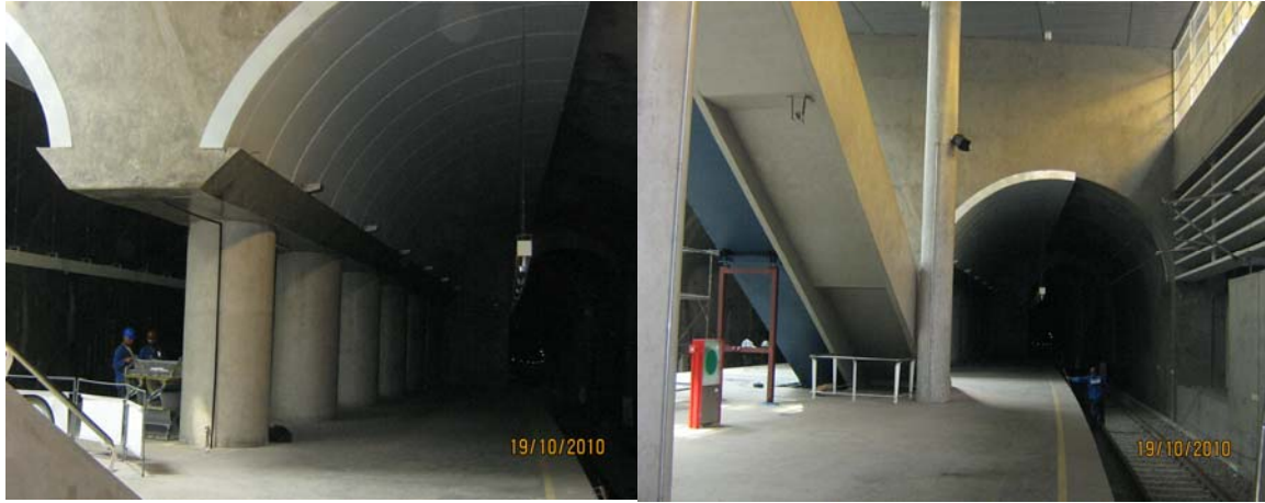
Figura 3.30 – Emboque Lapa após a conclusão das obras civis
