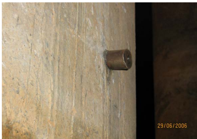
Figura 7.7 – Pino de recalque instalado na viga frontal do prédio da Pizzaria
