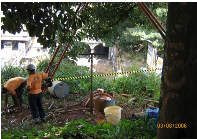
Figura 4.2 – Sondagem à percussão realizada ao topo do túnel
