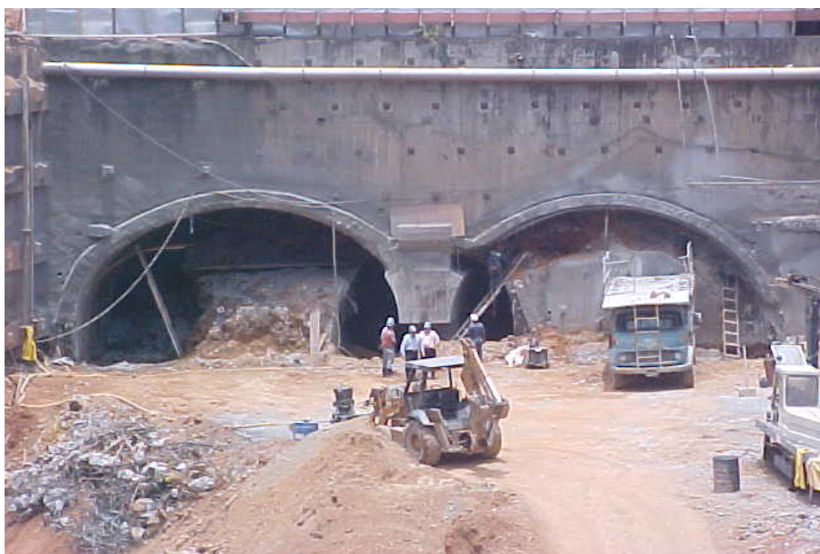
Figura 3.23 - Execução do 1º avanço de 1,0 m na via 2 e demolição do túnel piloto junto à via 2.
