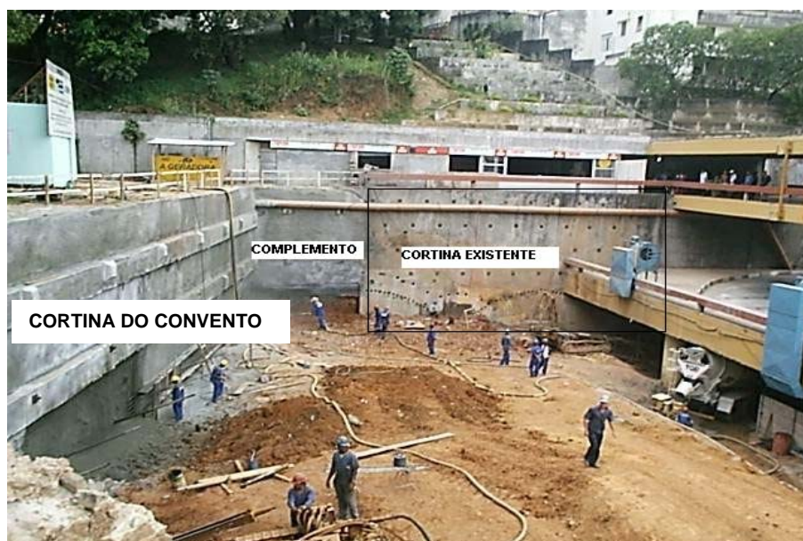
Figura 3.28 – Estrutura de contenção do emboque Lapa
