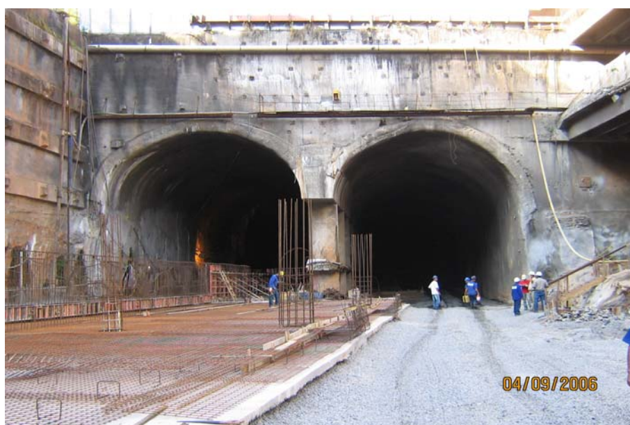
Figura 3.27 - Finalização dos trabalhos com a execução e conclusão do revestimento secundário concomitante com a instalação das telas e execução do concreto projetado
