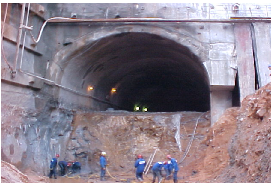
Figura 3.24 – Execução de rebaixo da via 1.
