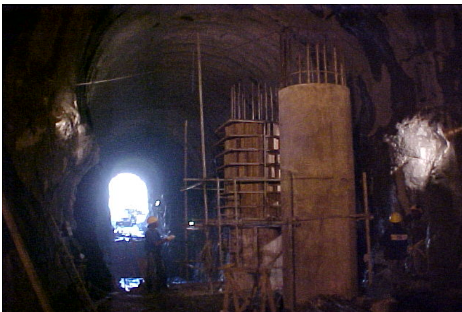
Figura 3.21 - Execução dos pilares deixando esperas para as vigas e lajes
