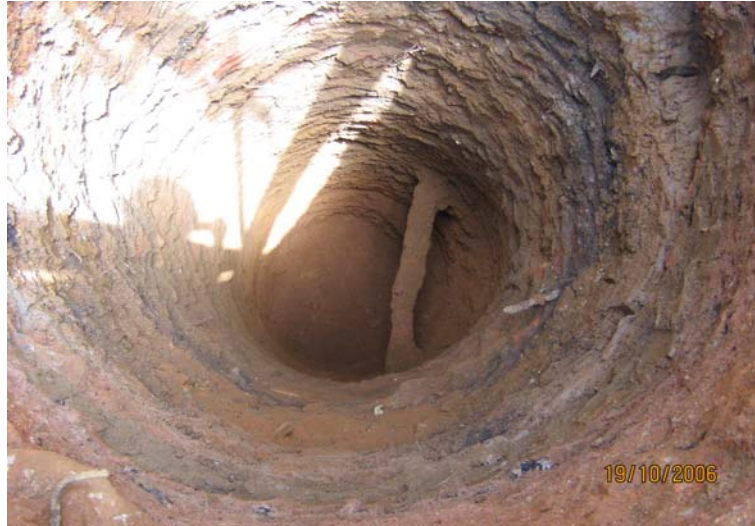
Figura 4.27 – Poço 02, intercessão com linha de tirante da cortina de contenção do Convento da Lapa.
