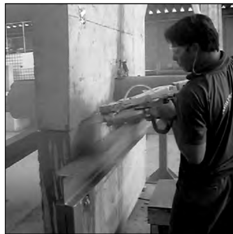
Figura 4.98 – Ferramentas utilizadas para o corte das lajes
