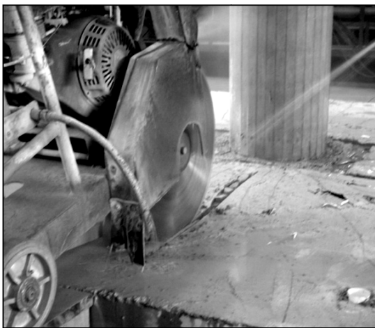
Figura 4.98 – Ferramentas utilizadas para o corte das lajes
