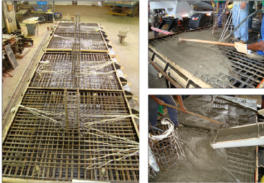
Figura 3.24 – Concretagem das lajes
