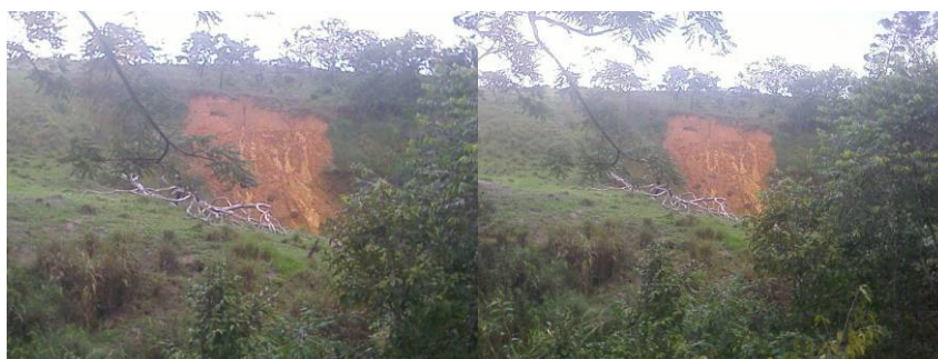
Figura 6.10 – Desbarrancamento de encosta a montante da seção de controle.
