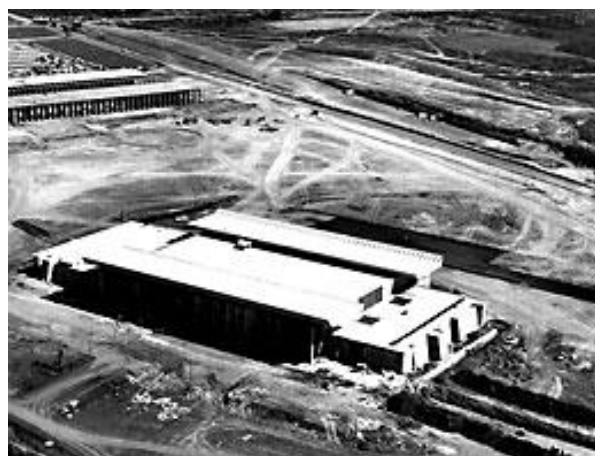
Figura 1.5 - Construção do edifício da Biblioteca Central /BCE - Arquivo CEDOC (1960)
