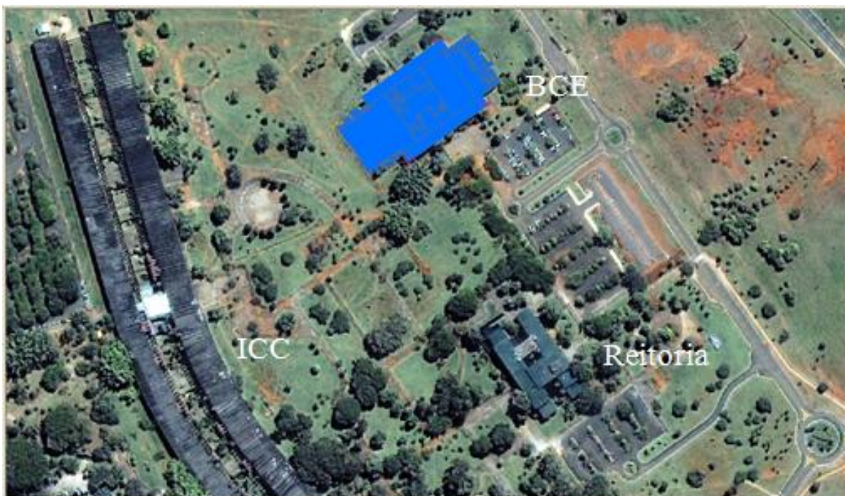
Figura 1.3 - Localização do edifício da Biblioteca Central/BCE na Praça Maior do Campus Universitário Darcy Ribeiro
