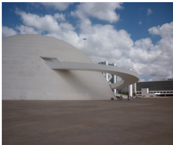
Figura 2.5 – Rampa Externa do Museu da República.
