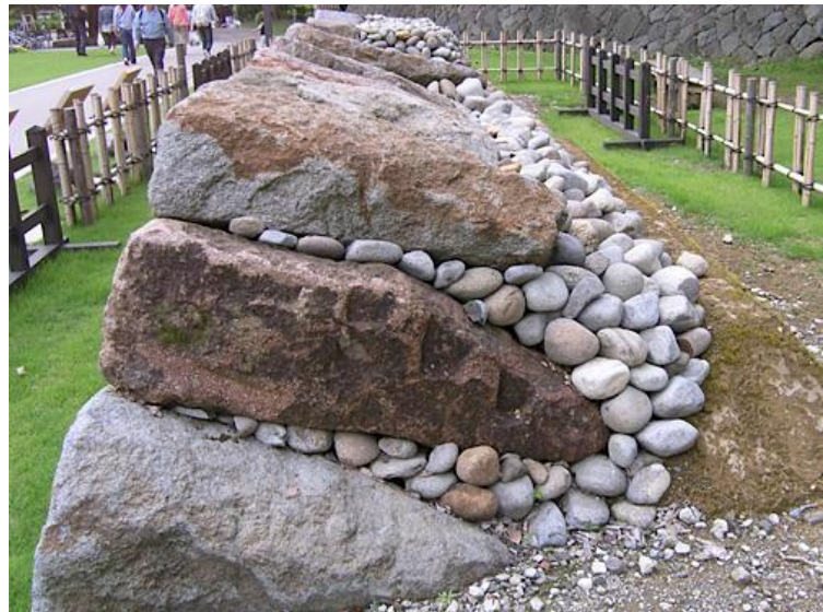
Figura 102. Sistema construído das muralhas do castelo de Kanazawa. Fonte: < www.jcastle.info > acessado em 29/10/2009
