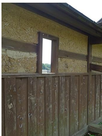
Figura 82. Parede sem reboco do castelo de Sakasai. Fonte: <www.jcastle.info> acessado em 29/10/2009
