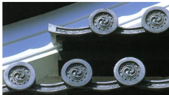
Figura 167. Detalhe do telhado. Fonte: Ibid., p.49
