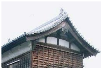
Figura 161. Telhado kirizuma do castelo de Fukuoka. Fonte: Ibid.
