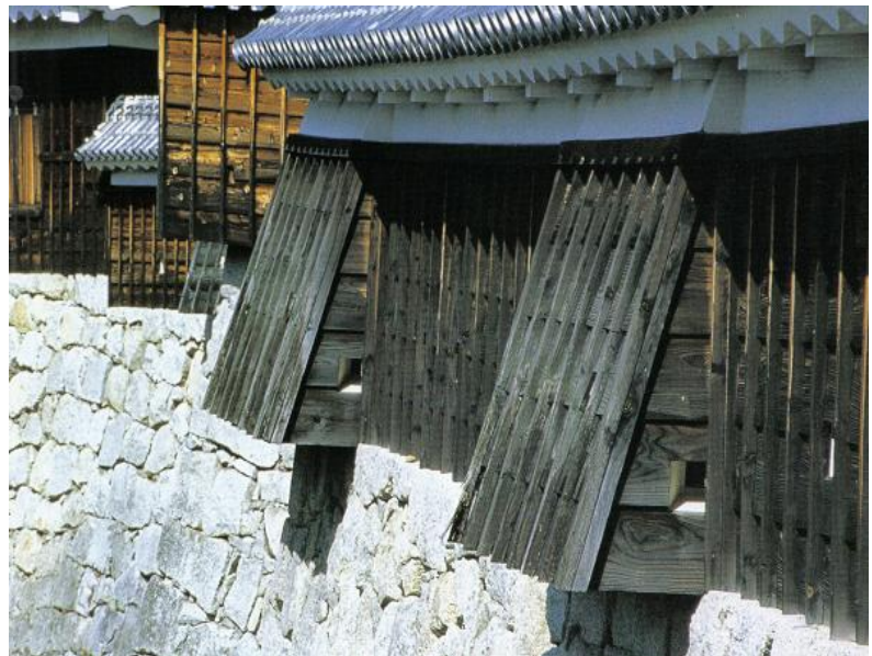
Figura 89. Ishi-otoshi , avanço com janelas para arqueiros e alçapão para arremesso de coisas do castelo de Matsuyama. Fonte: Mitchelhill, Castles of the samurai . op. cit. p.30
