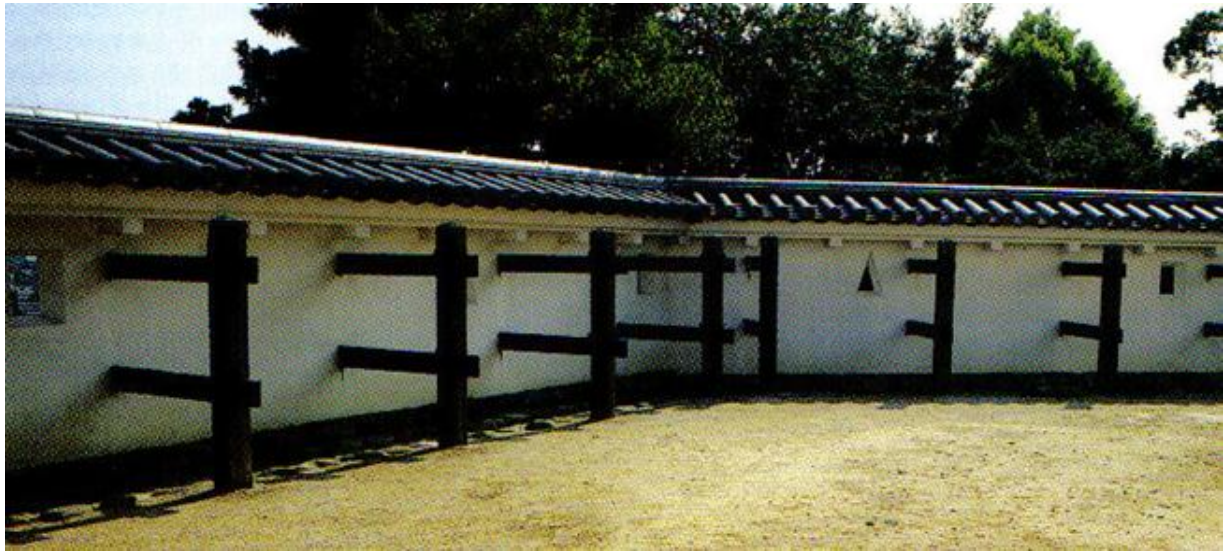
Figura 85. Apoio da parede do castelo de Kakegawa. Fonte: Turnbull, Japanese Castles 1540-1640. op.cit. p.10
