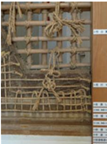
Figura 81. Estrutura da parede do castelo de Utsunomiya. Fonte: < www.jcastle.info > acessado em 29/10/2009
