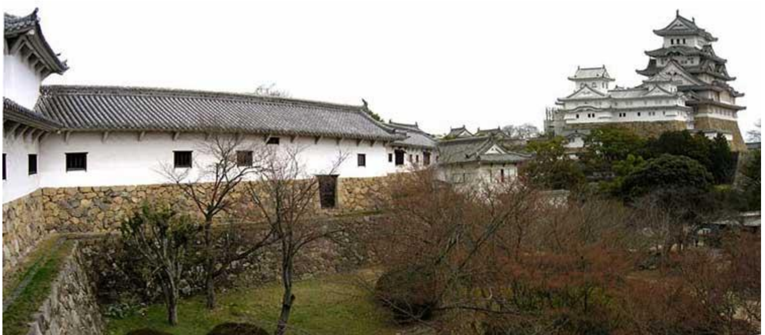
Figura 216. Muro de defesa entre os portões Ro-no-mon e Ha-no-mon pelo lado de dentro. Fonte: < www.jcastle.info > acessado em 29/10/2009
