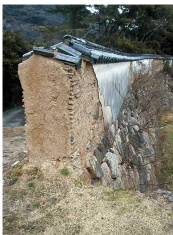
Figura 31. Parede de terra batida em Hagi. Fonte: < www.jcastle.info > acessado em 29/10/2009
