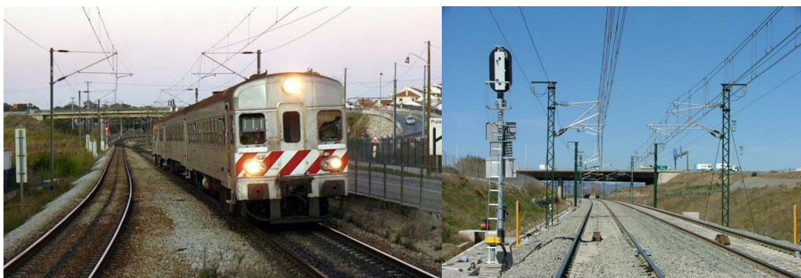
Figura 2.6 – Eletrificação em ferrovias.
