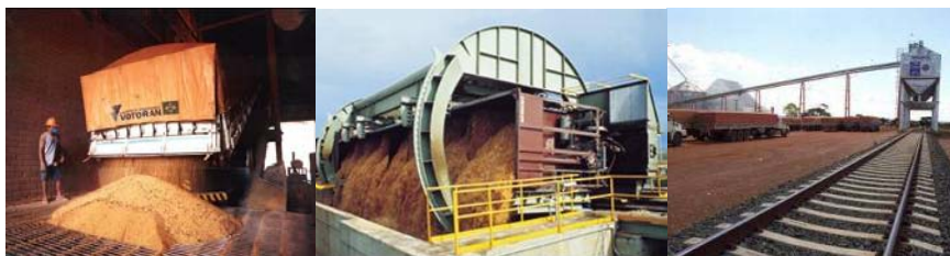
Figura 7.5 – Moega, virador de vagão e silos de carregamento.
