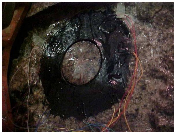
Figura 3.98 – Furo de subfuração executado ( undercoring ).
