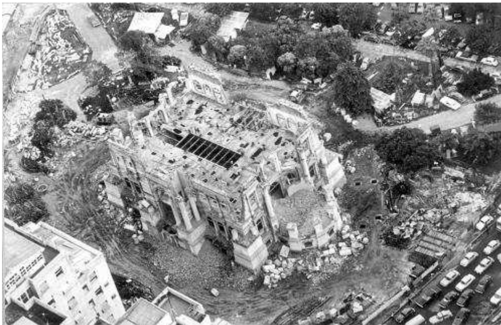
Figura 2. 2 - Demolição do Palácio Monroe para dar lugar à praça da estação de metrô da Cinelândia
