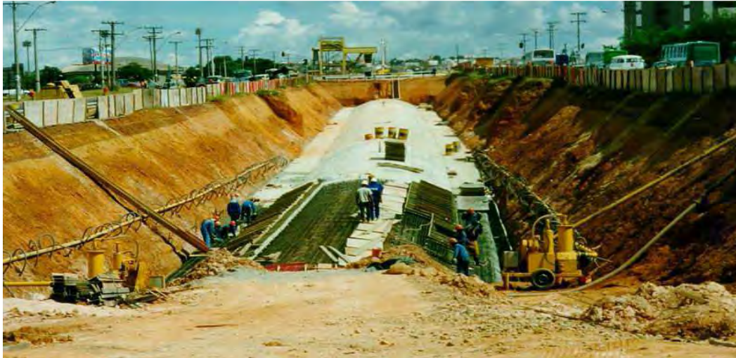
Figura 2.20 – Instalação da laje de teto do túnel invertido no metrô de Brasília – Túnel Taguatinga (CARVALHO & PEIXOTO, 2006).
