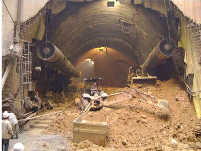
Figura 2.16 – Túnel em NATM em construção – Linha 4 – Amarela – São Paulo/SP.
