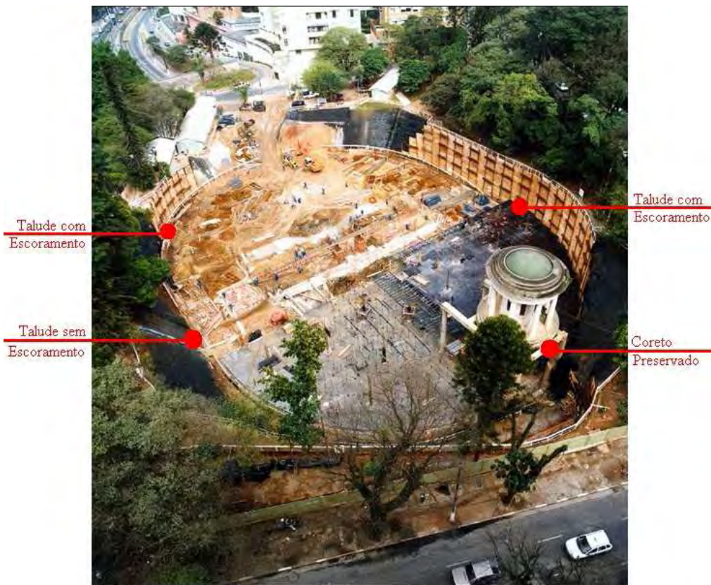
Figura 2.19 – Construção da garagem Trianon – SP (CARVALHO & PEIXOTO, 2006).
