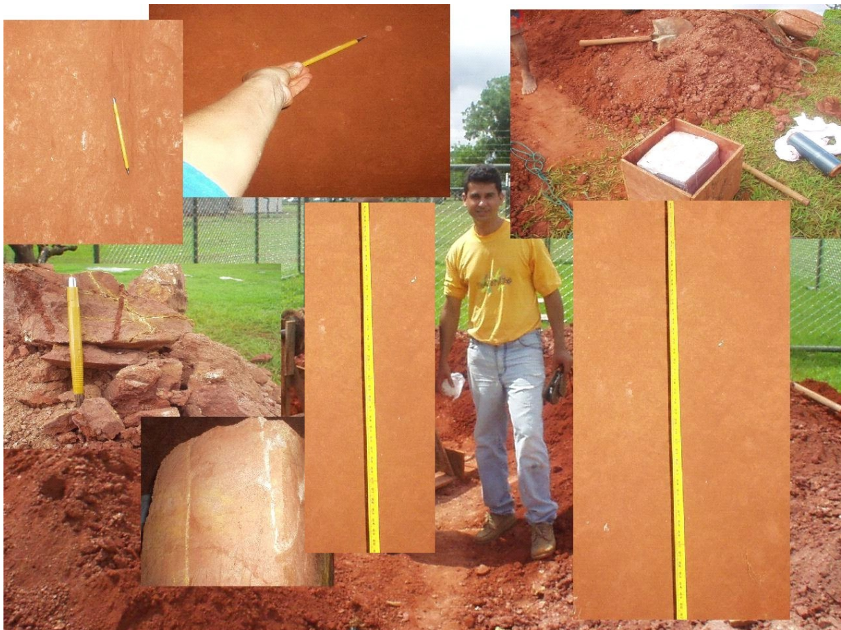
Figura 5.14 – Execução do poço para retirada de amostras indeformadas.
