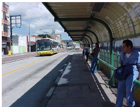
Figura 6.5 – Estação na Avenida Bento Gonçalves.
