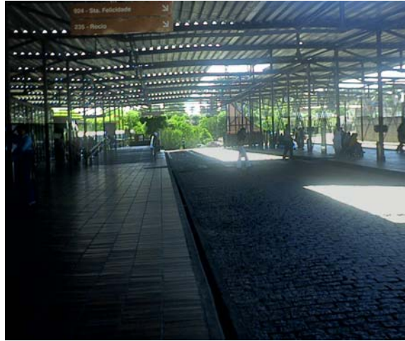
Figura 6.12 – Pavimento com paralelepípedos dentro do terminal
