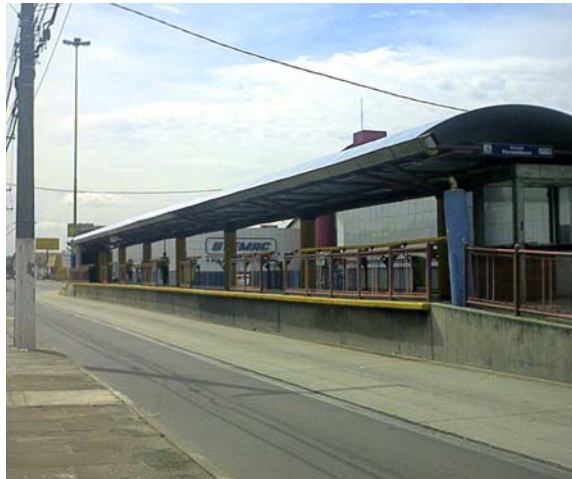
Figura 6.4 - Estação na Avenida Sertório
