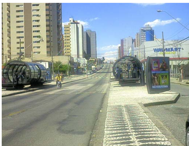
Figura 6.11 – Pavimento de concreto nas proximidades das estações tubo
