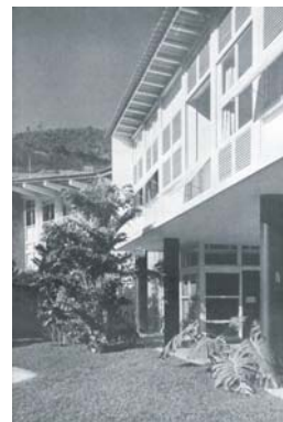
fig. 81. Casa George Hime: detalhe
