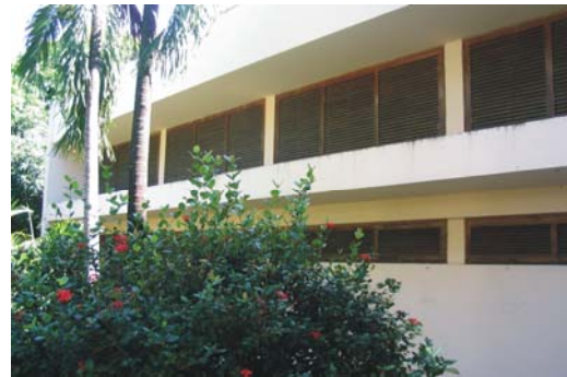
fig. 54. Casa David Cortellazzi: vista do pátio
