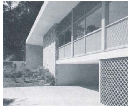
fig. 97. Casa Couto e Silva: detalhe da fachada
