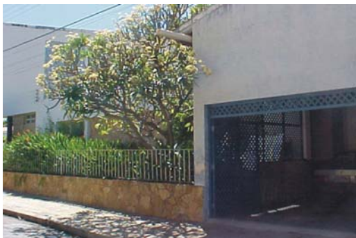
fig. 28. Casa Zenon Rocha: jardim e garagem
