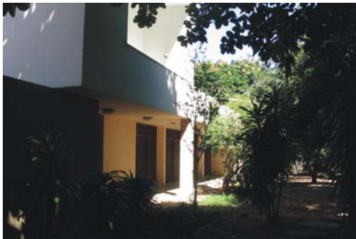
fig. 53. Casa David Cortellazzi: vista de norte
