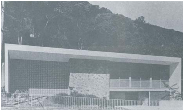
fig. 96. Casa Couto e Silva: fachada principal
