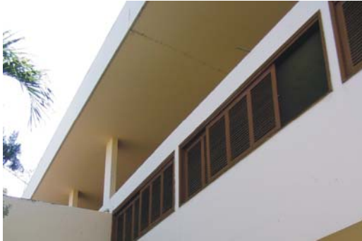
fig. 51. Casa David Cortellazzi: detalhe da cobertura
