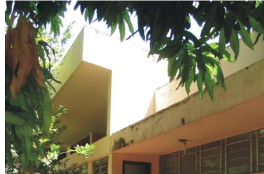
fig. 52. Casa David Cortellazzi: detalhe da cobertura
