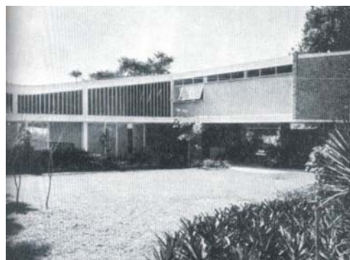
fig. 85. Casa Jadir de Souza: fachada posterior
