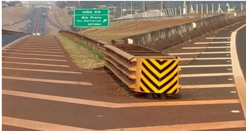
Figura 2.6 Exemplo de Defesa Metálica, Atenuador de Impacto e New Jersey Fonte: CNT, 2021.
