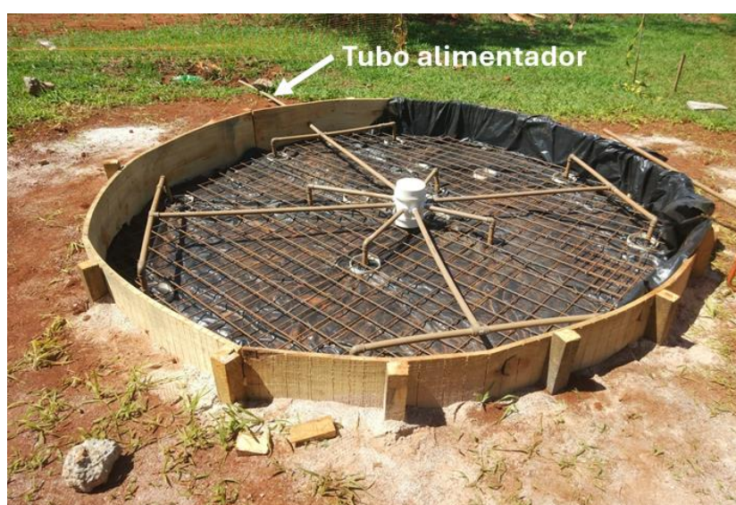
Figura 3.8. Modelo de Referência antes da concretagem, evidenciando o sistema de inundação.
