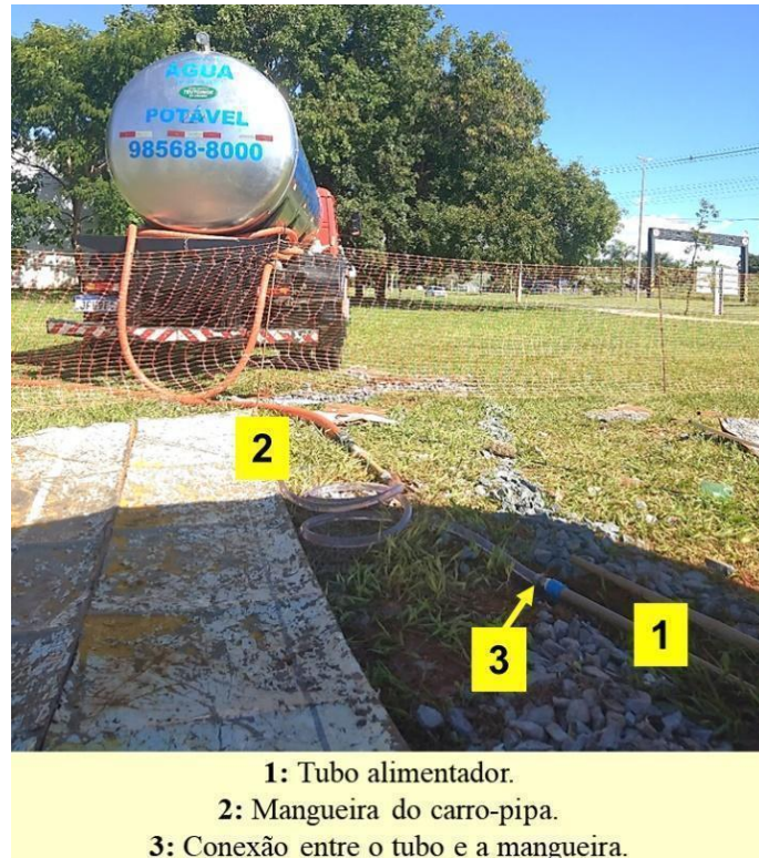
Figura 3.11. Registro da inundação do subsolo abaixo do Modelo Reforçado utilizando carro-pipa.
