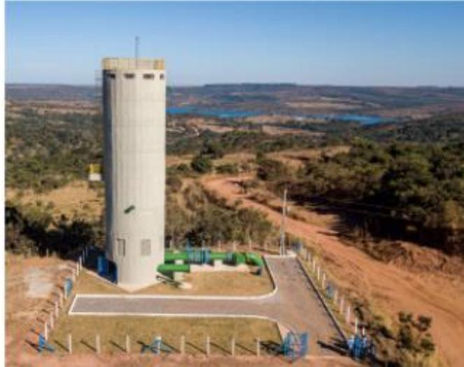
Figura 3.5 – Tanque de Alimentação Unidirecional (ADASA, 2020).
