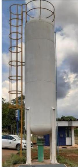
Figura 3.4 – Reservatório Hidropneumático (Morimoto, 2023).
