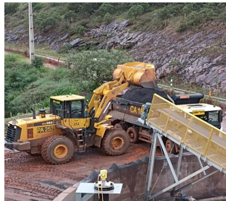
c) Carregamento do rejeito
