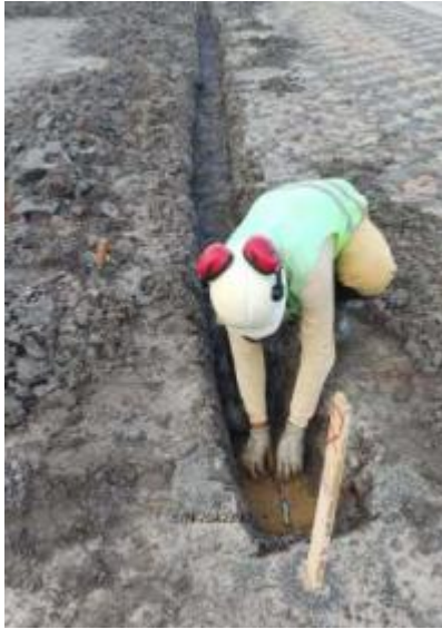
a) Locação do sensor
