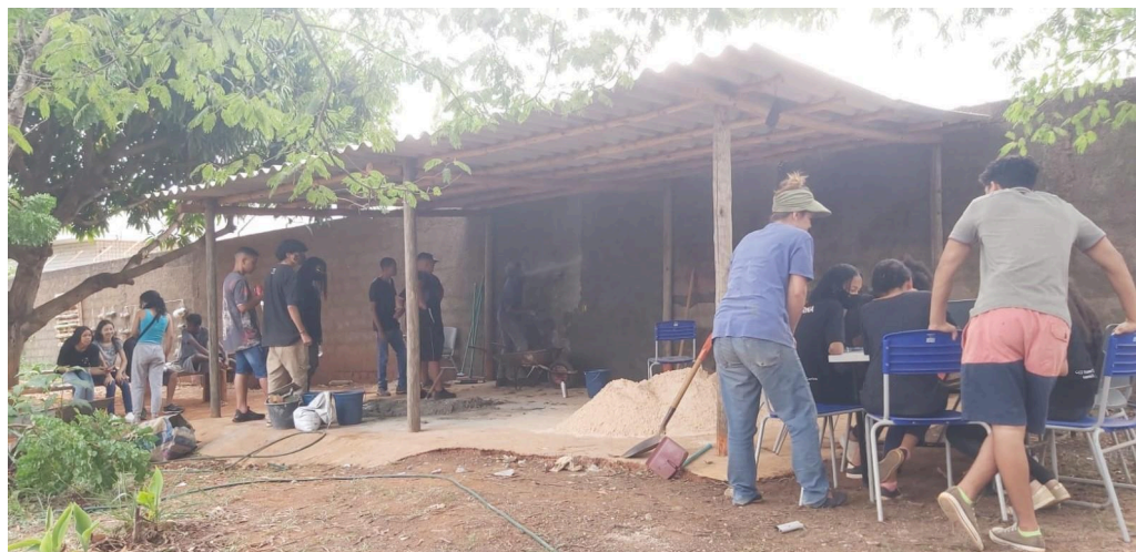
Figura 1 - Genivaldo rebocando a parede
