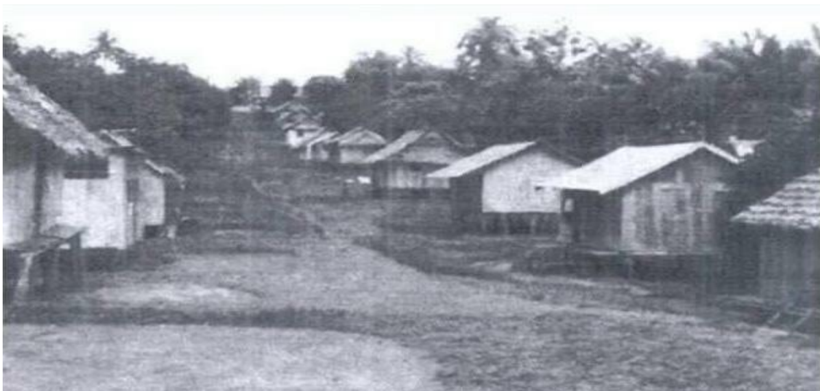
Figura 19: Casas construídas em fileiras, feitas com Paxiúba (Yura) e Caranã, com madeira e alumínio, do principal rua Avelino, da Comunidade Me'cürane.
