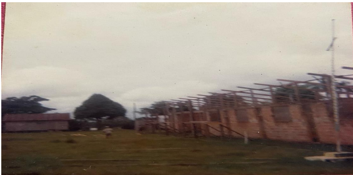
Figura 12: Escola em construção (de alvenaria), da Escola Municipal Dom Pedro I.
