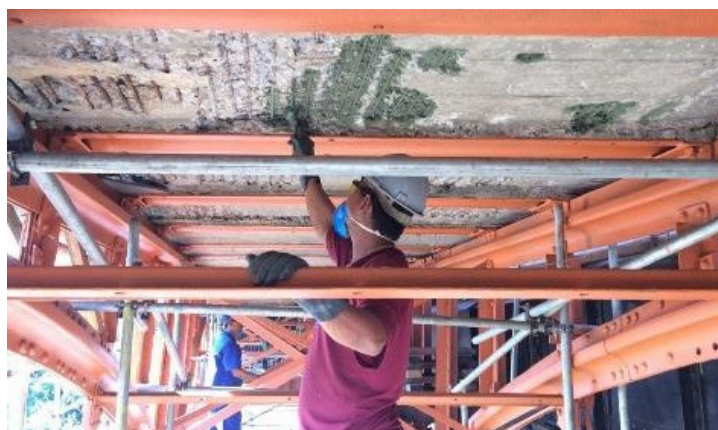
FIGURA 15: RECUPERAÇÃO DA PARTE INFERIOR DA LAJE
