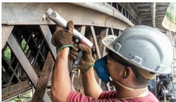
FIGURA 12: LIMPEZA DA PISTOLA DE AGULHAS
