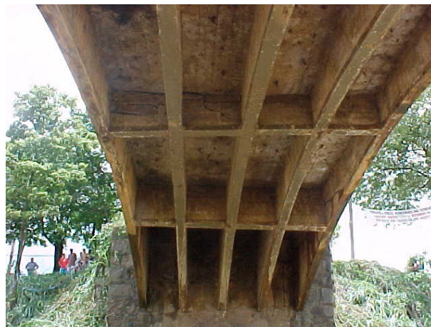
FIGURA 10: VISTA INFERIOR DAS VIGAS TRANSVERSAIS CONECTANDO AOS ARCOS
