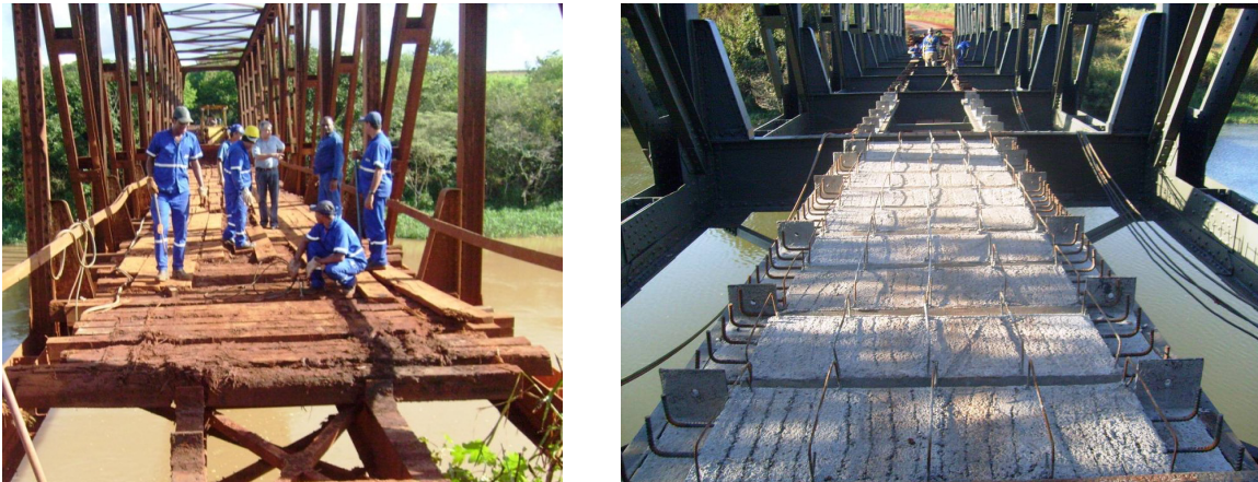
Figura 12: Detalhe da remoção do estrado original e das pré-lajes entre longarinas
