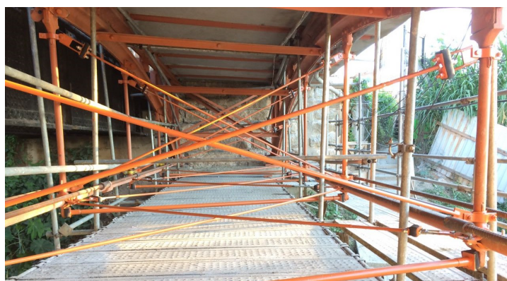
FIGURA 18: CONTRAVENTAMENTO COM DIAGONAIS CRUZADAS
