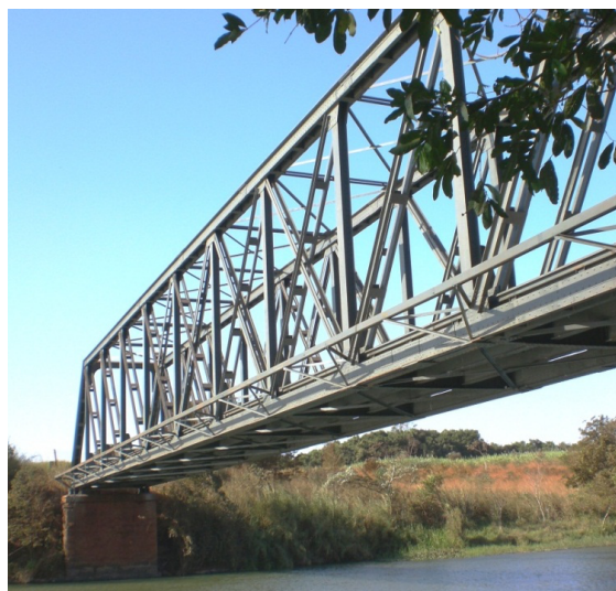
Figura 15: Vista inferior durante a recuperação – notar estrutura metálica do passeio
