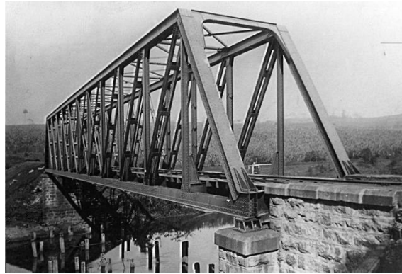
FIGURA 2: PONTE AO TÉRMINO DA SUA CONSTRUÇÃO (FONTE: REVISTA STA ROSA DE VITERBO – 81 ANOS. TEXTO: “A ESTRADA DE FERRO, ANO 1991”, P. 11.)
