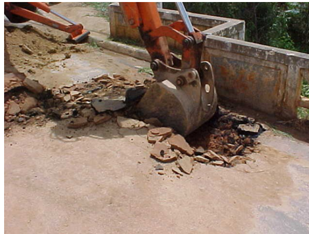
FIGURA 4: ESCAVAÇÃO PARA VERIFICAR A CAMADA DE SOLO NO TABULEIRO DA PONTE
