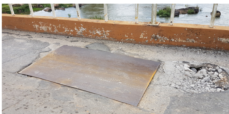
FIGURA 16: SUPERFÍCIE SUPERIOR DA LAJE
