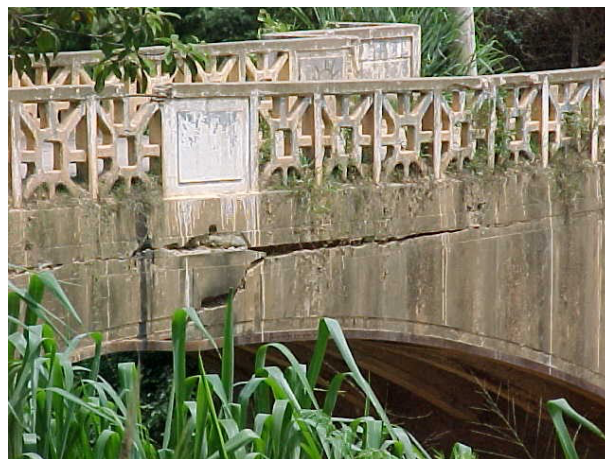
FIGURA 8. VISTA DA PONTE NO OUTRO LADO DO RECALQUE
