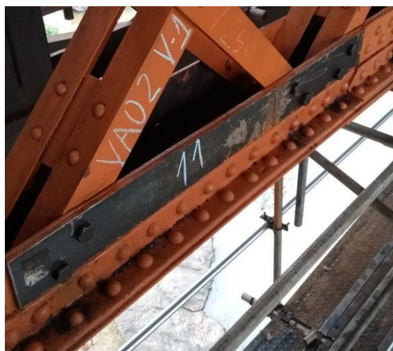
FIGURA 21: RECUPERAÇÃO DAS CONEXÕES DAS DIAGONAIS
