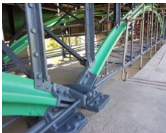
FIGURA 26: VÃOS EM ARCO REFORÇADO
