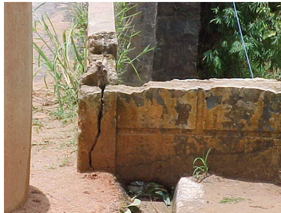
FIGURA 6: Esvaziamento de água da chuva no tabuleiro da ponte
