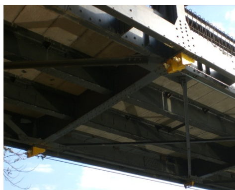
FIGURA 16. DETALHE DO POSICIONAMENTO DOS DISPOSITIVOS DE PROTENSÃO (EM AMARELO)
