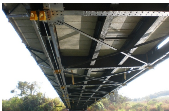
FIGURA 16. DETALHE DO POSICIONAMENTO DOS DISPOSITIVOS DE PROTENSÃO (EM AMARELO)
