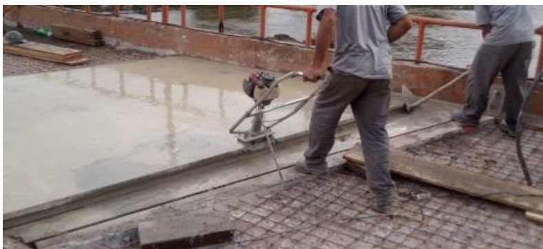
FIGURA 17: REFORÇO DA LAJE
