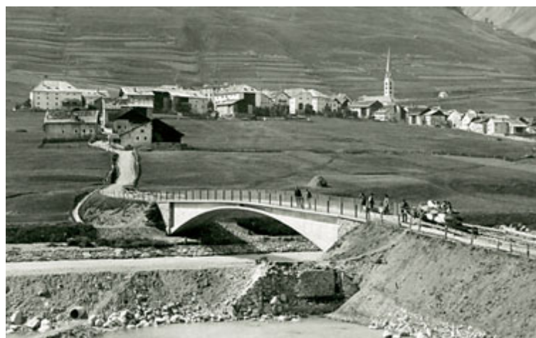
Figura 8: Ponte Zuoz sobre o rio Inn
