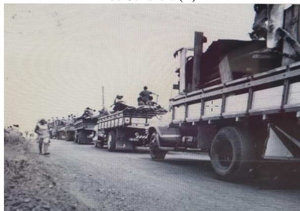
Fotografia 6 – Primeiros movimentos para a construção de Ceilândia (II)
