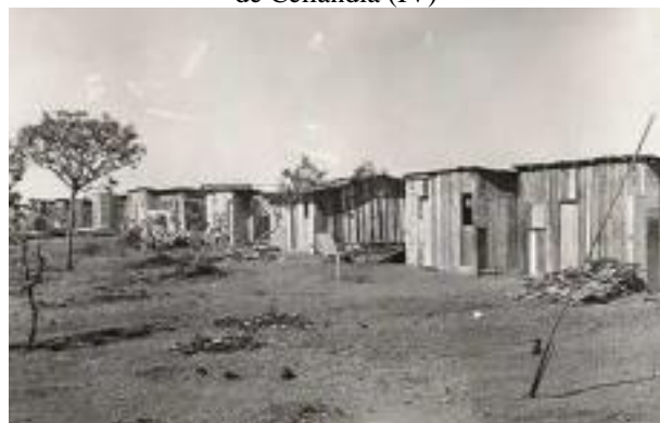
Fotografia 8 – Primeiros movimentos para a construção de Ceilândia (IV)
