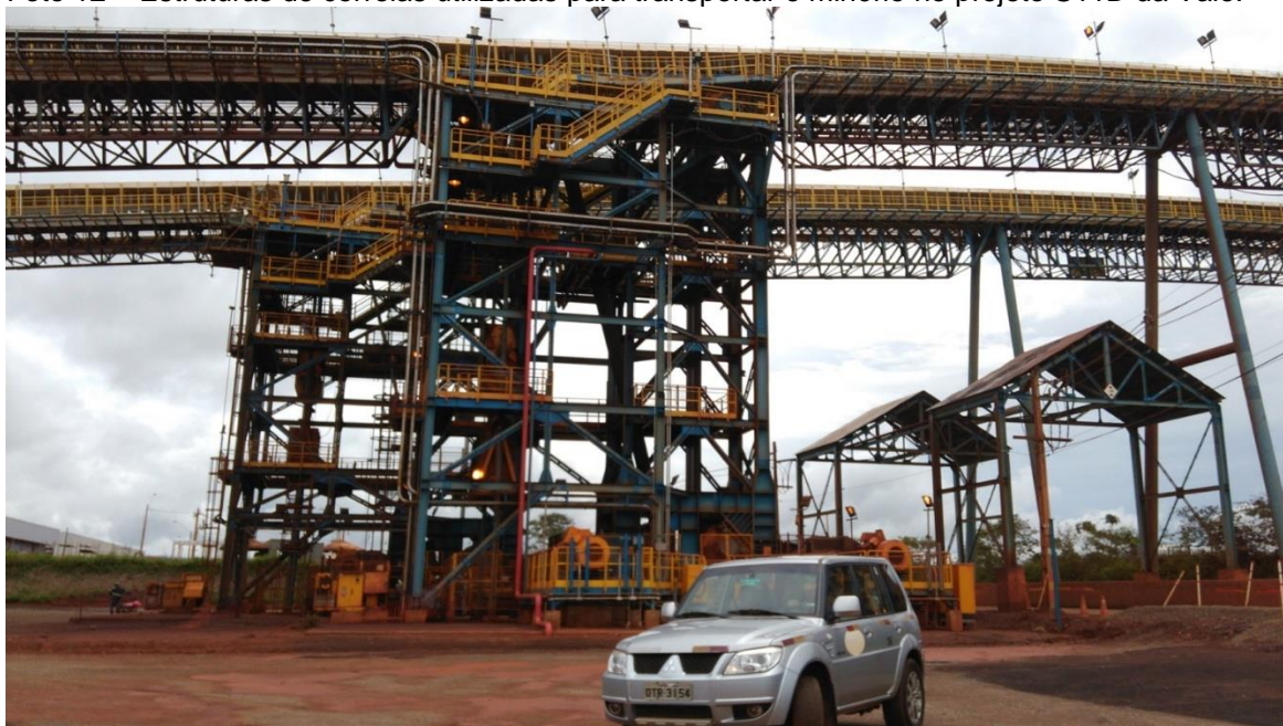
Foto 12 – Estruturas de correias utilizadas para transportar o minério no projeto S11D da Vale.
