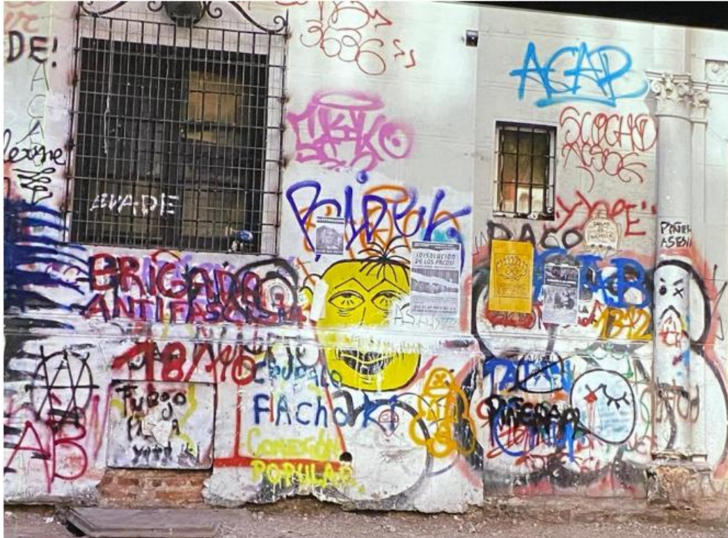
Figura 1– Foto de muro no bairro Bellavista
