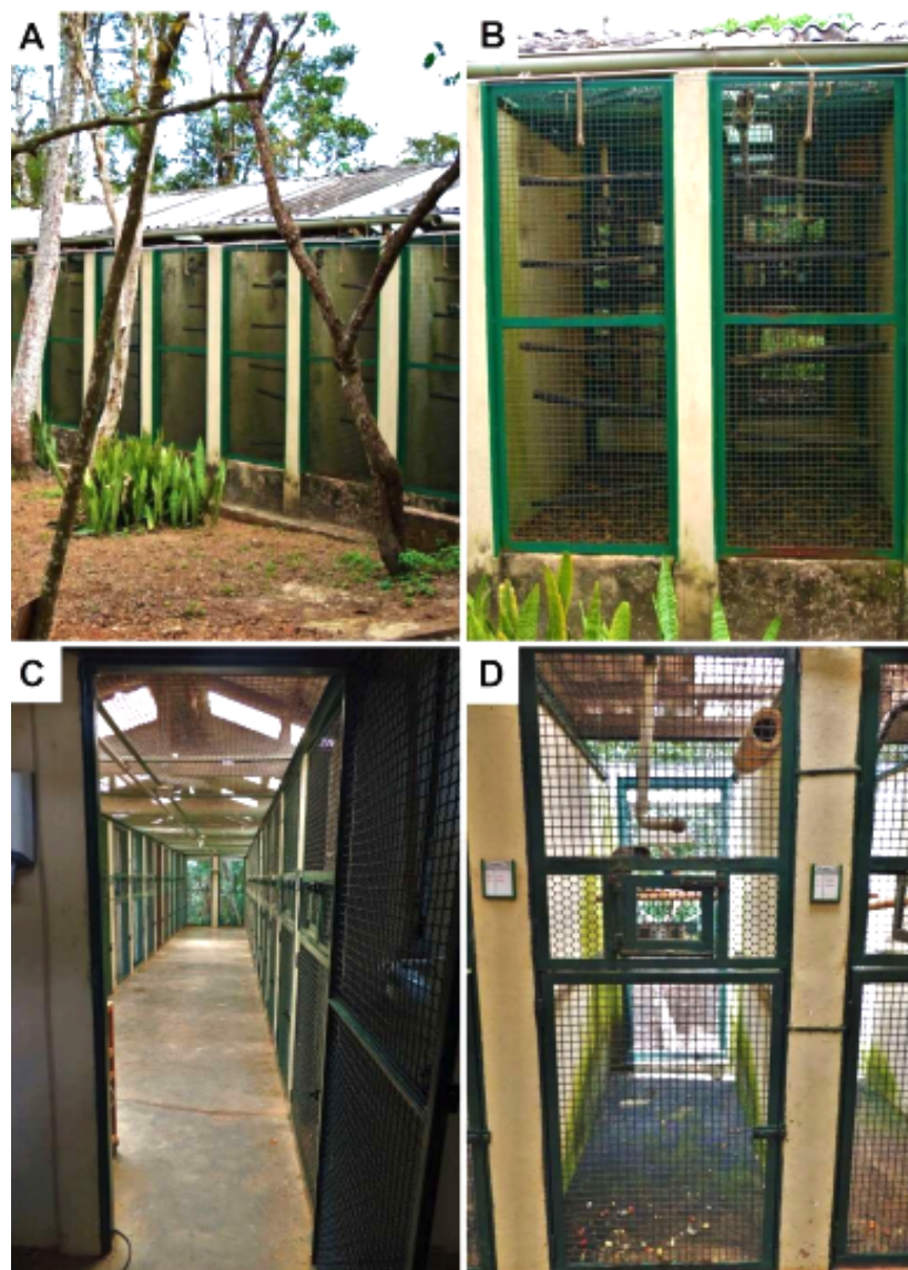
Figura 3.2. Fotografias do Pavilhão de Calitriquídeos do Centro de Primatologia da Universidade de Brasília (CUnB), onde os micos-estrela foram alojados. (A) e (B) Vista externa dos viveiros; (C) Vista interna do corredor de segurança com uma fileira de 12 viveiros em cada lado; (D) Vista de um viveiro a partir do corredor central de segurança. (Fotos (A) e (B): Marília Barros. Fotos (C) e (D): Fernando Magela).
