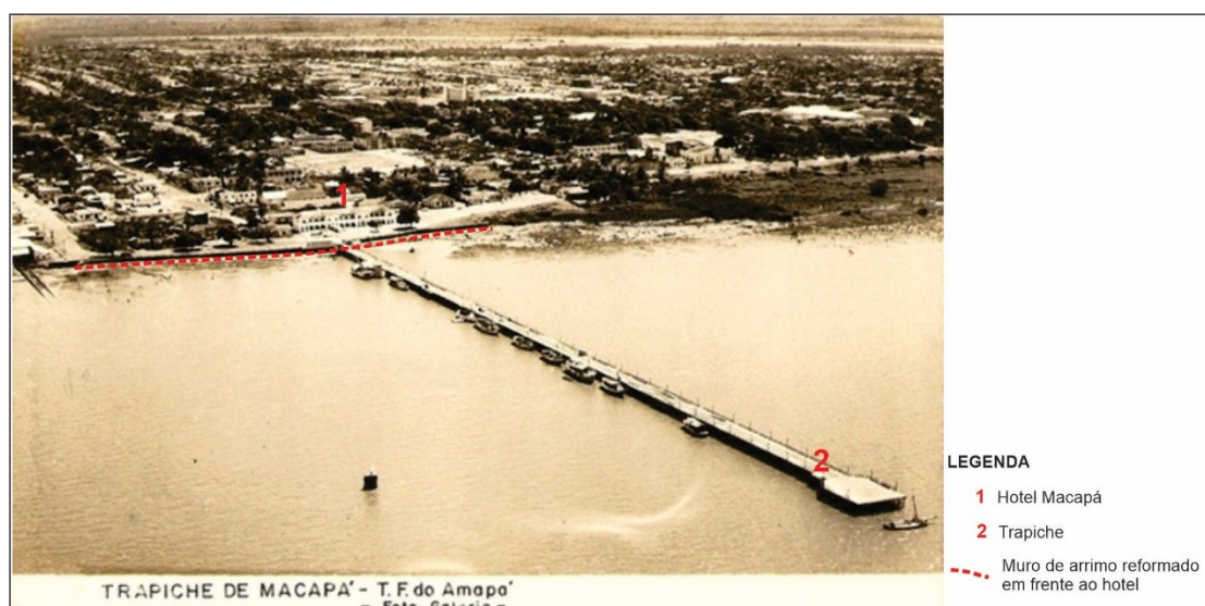
Figura 23 - Início da construção do muro de arrimo em frente ao hotel Macapá e trapiche da cidade
