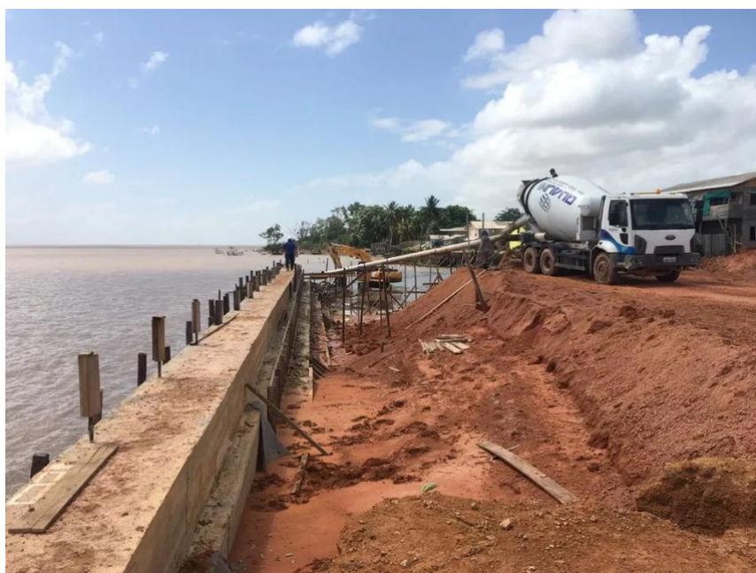
Figura 42 - Muro de arrimo em construção na orla do bairro Araxá
