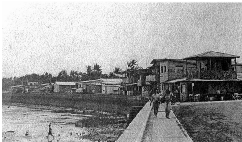
Figura 26 - Muro de arrimo recém-construído na orla do bairro Santa Inês em meados de 1982
