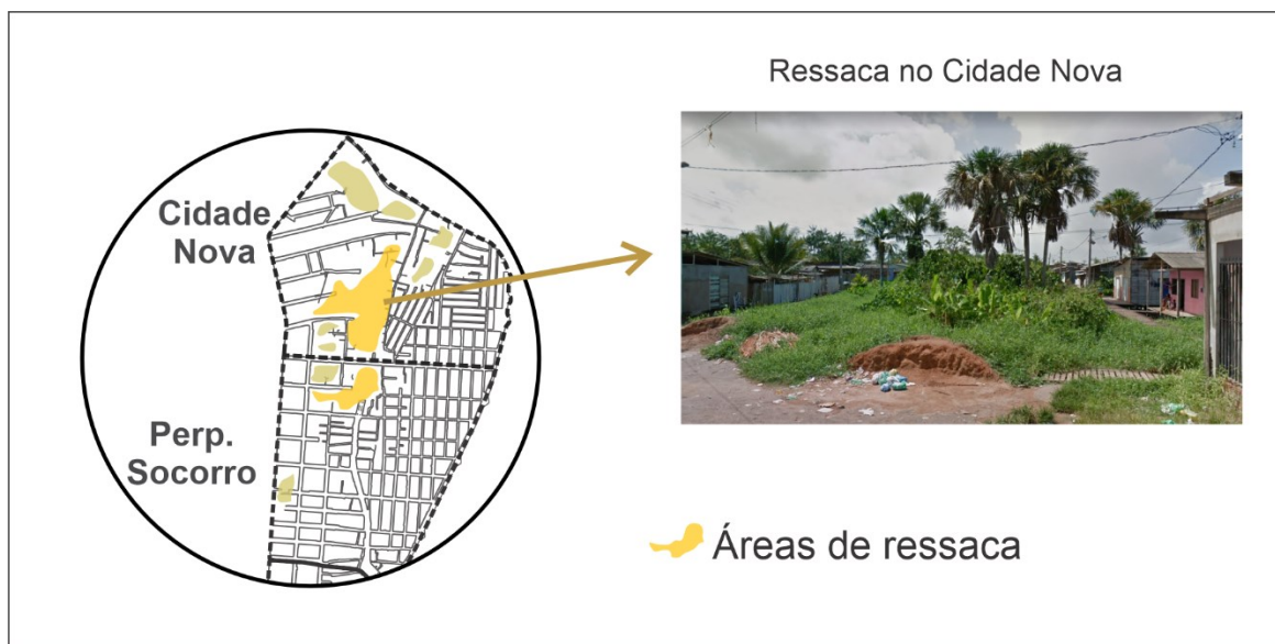
Figura 48 - Área de ressaca ocupada no Cidade Nova sujeitas a inundação
