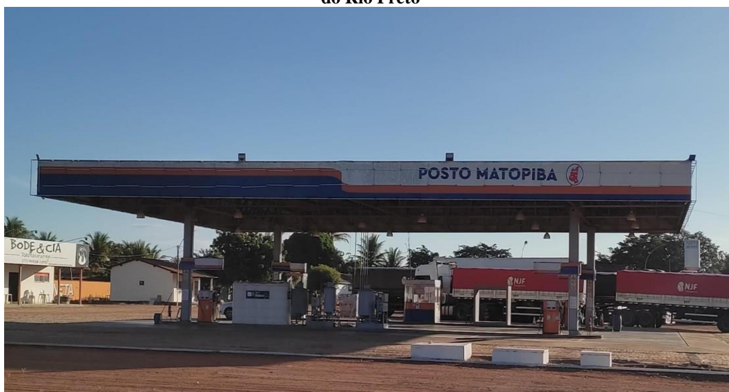
Imagem 4 - Posto de gasolina Matopiba na rodovia federal BR 135, trecho que liga Barreiras a Formosa do Rio Preto
