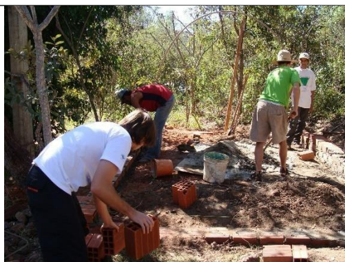
Mutirão de construção do viveiro comunitário “Berço do Urubu” em julho de 2009. Fonte: Salve o Urubu (2023).
