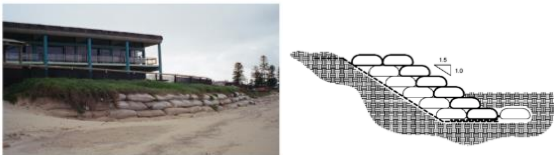
Figura 2.4 - Revestimento típico de geofôrmas preenchidas com areia (0,75 m 3 ) (Saatooff et al. , 2007).
