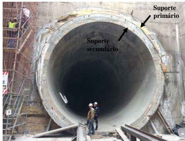
Figura 1.1. Suporte dobro usado na construção de túneis na Cidade de México.
