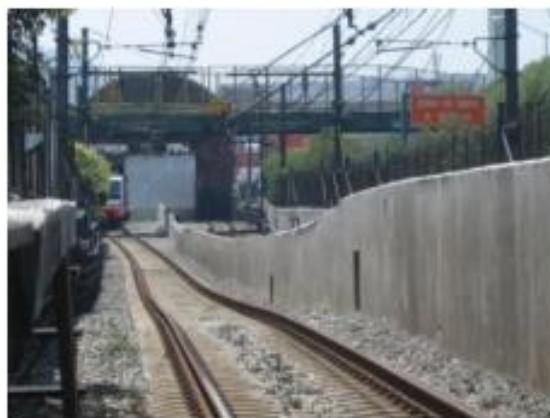
Figura 3.9. Deformação da caixa da linha A do Metrô (Zaldívar, 2013).
