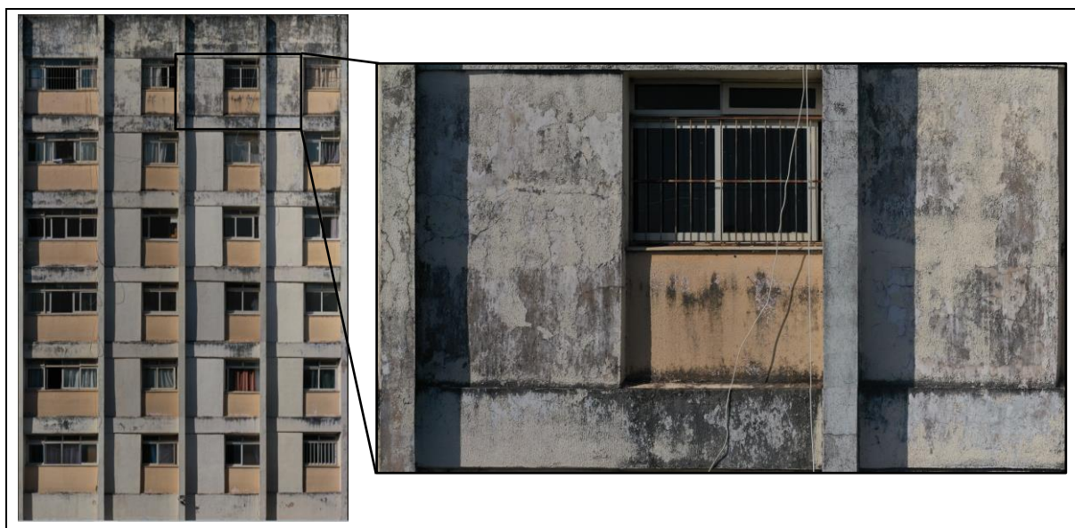
Figura 5.3 – Exemplificação da qualidade e do nível de detalhe dos ortomosaicos obtidos por ortogonalização (Amostra A2.1).
