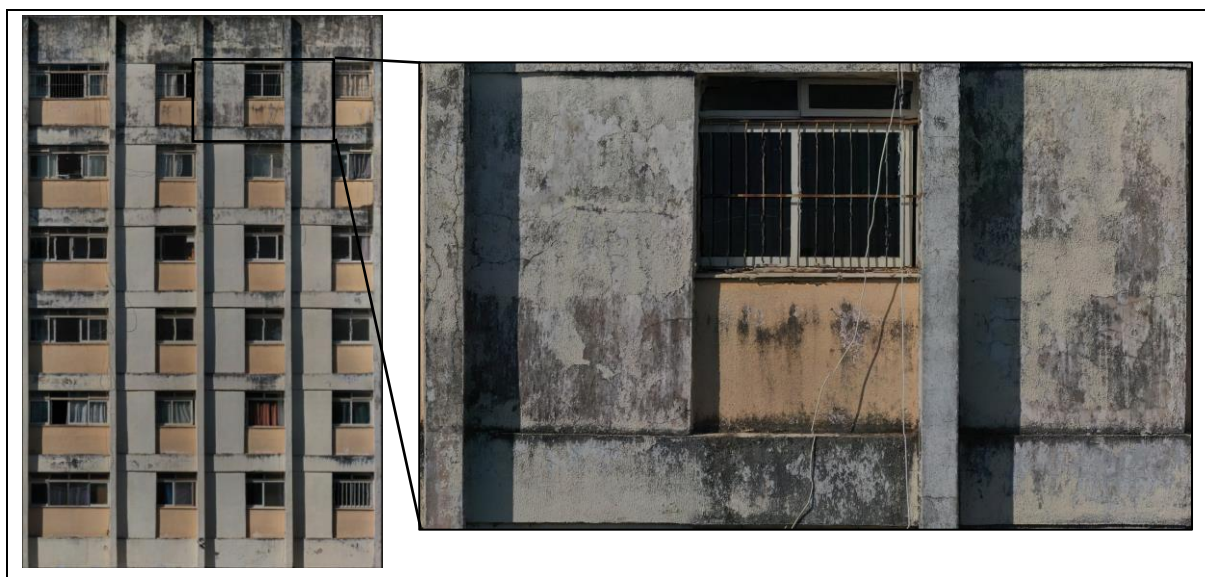
Figura 5.5 – Exemplificação da qualidade e do nível de detalhe dos ortomosaicos obtidos por processamento digital de imagens (Amostra A2.1).
