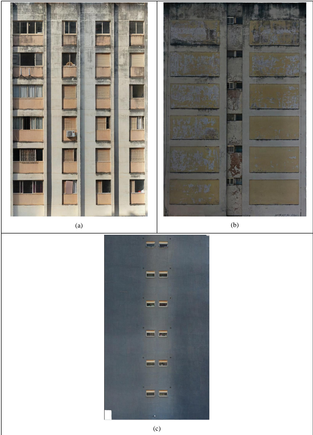
Figura 5.25 – Exemplos de amostras de fachada: (a) com alto detalhamento (A1.3); (b) com médio detalhamento (A3.1); (c) com baixo detalhamento (A2.2).
