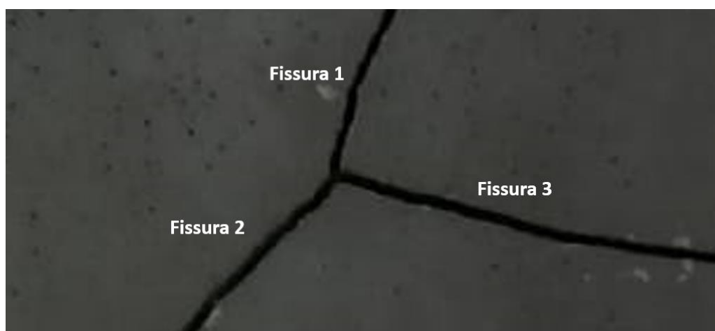
Figura 62 -Identificação das fissuras da placa L3
