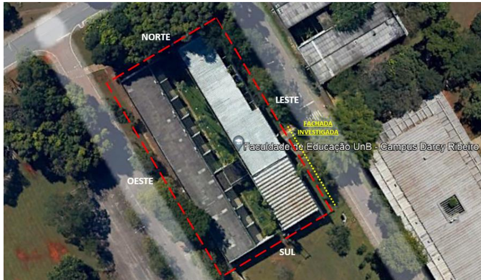
Figura 49 - Fachada de argamassa inspecionada por termografia
