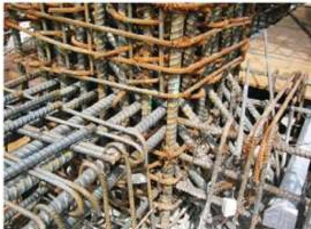
Figura 1.1 - Congestionamento na conexão viga-pilar. Fonte: Hayek (2023).
