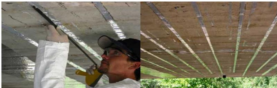
Figura 2.13 – Reforço com laminados de CFRP (Disponível em: aslanfrp.com/Aslan500/Aslan_500_Application_Photos.html . Acesso em: 16 de Agosto 2019)
