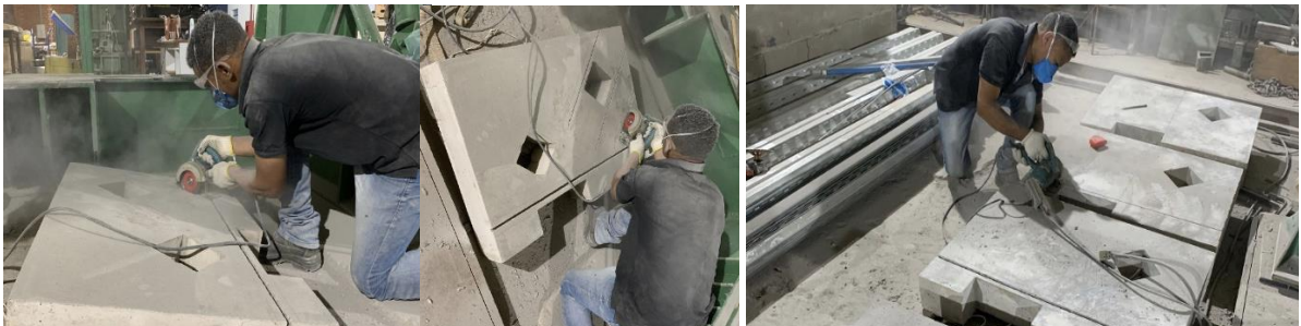
Figura 3.34 – Execução das aberturas na camada de cobertura do concreto
