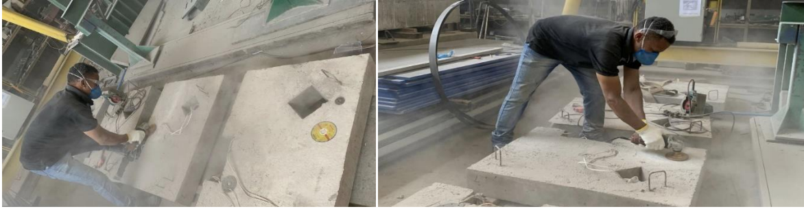
Figura 3.33 – Preparação da superfície do substrato do concreto
