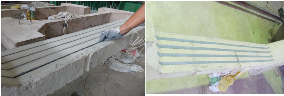
Figura 2.12 – Reforço de pilares com laminados de CFRP por NSM (ABREU NETA, 2017)
