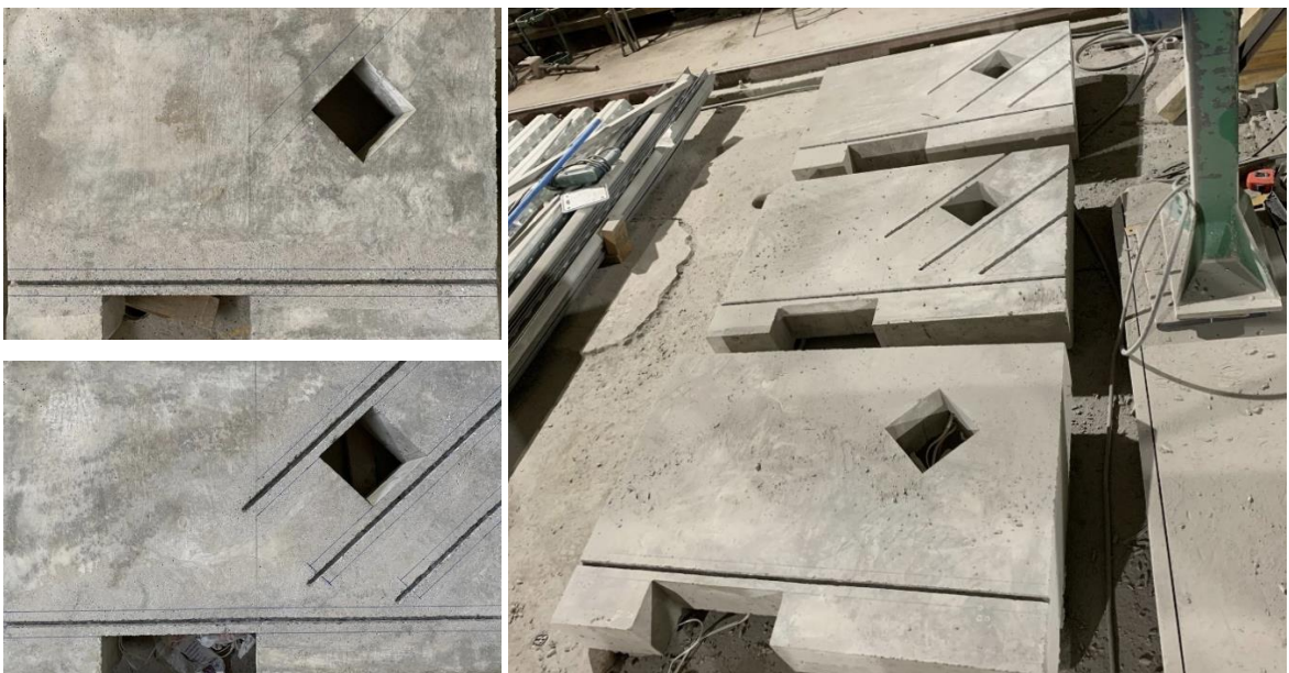
Figura 3.35 – Aspecto final dos cortes nas faces das vigas-parede
