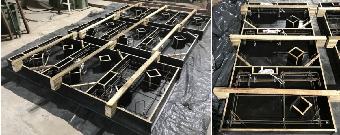
Figura 3.25 – Armaduras posicionadas nas formas
