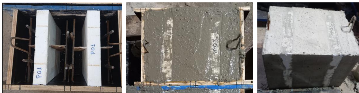
a) Instalação dos elementos construtivos
