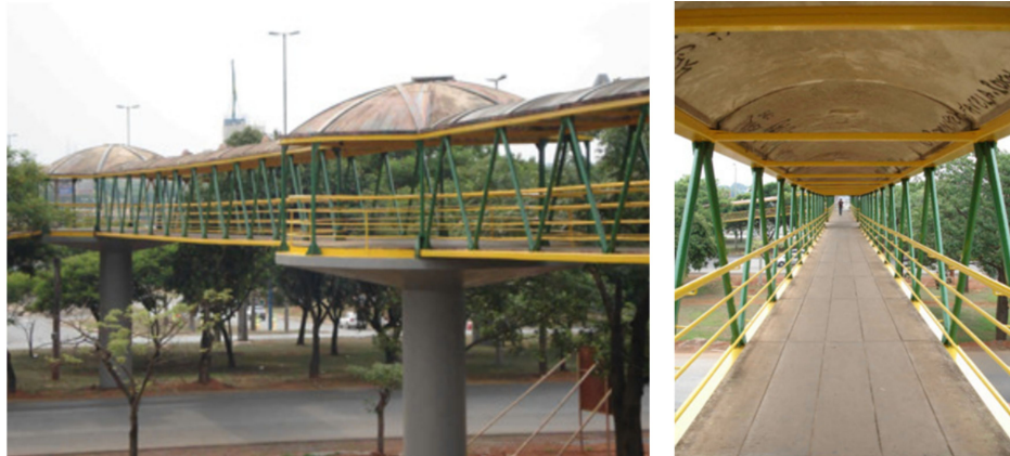
Figura 2.4 – Composição estrutural da Passarela sobre a E.P.I.A
