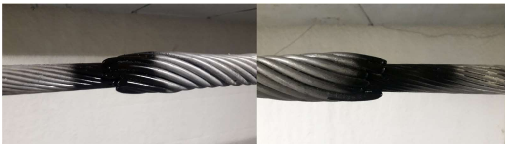
Figura 4.16 – Extremidade da emenda pintada para auxiliar a inspeção visual
