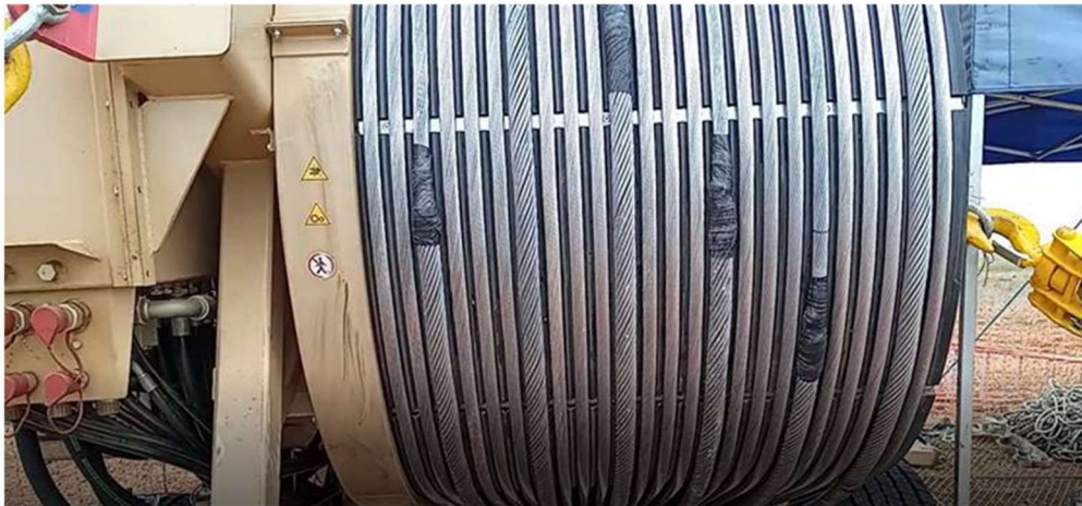
Figura 4.10 - Foto com evidência da passagem das emendas pelo tensionador (Fonte: Autoria Própria, 2021)
