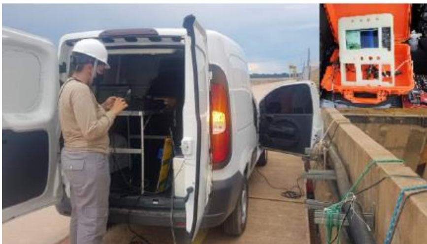
Figura 4.4 – Sistema acústico e de monitoramento da ictiofauna implementado no vertedouro da UHE Jirau. Fonte: Autores.
