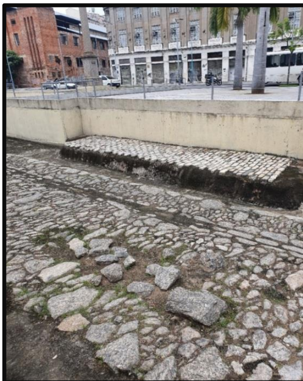
Imagem 12: vista da lateral esquerda do Cais do Valongo, com destaque para a diferença entre os níveis de pedras. Em primeiro plano, as pedras (gnaisse facoidal) do Cais do Valongo, em segundo plano, as pedras polidas do Cais da Imperatriz. (Foto: Marina Farias, 2021)
