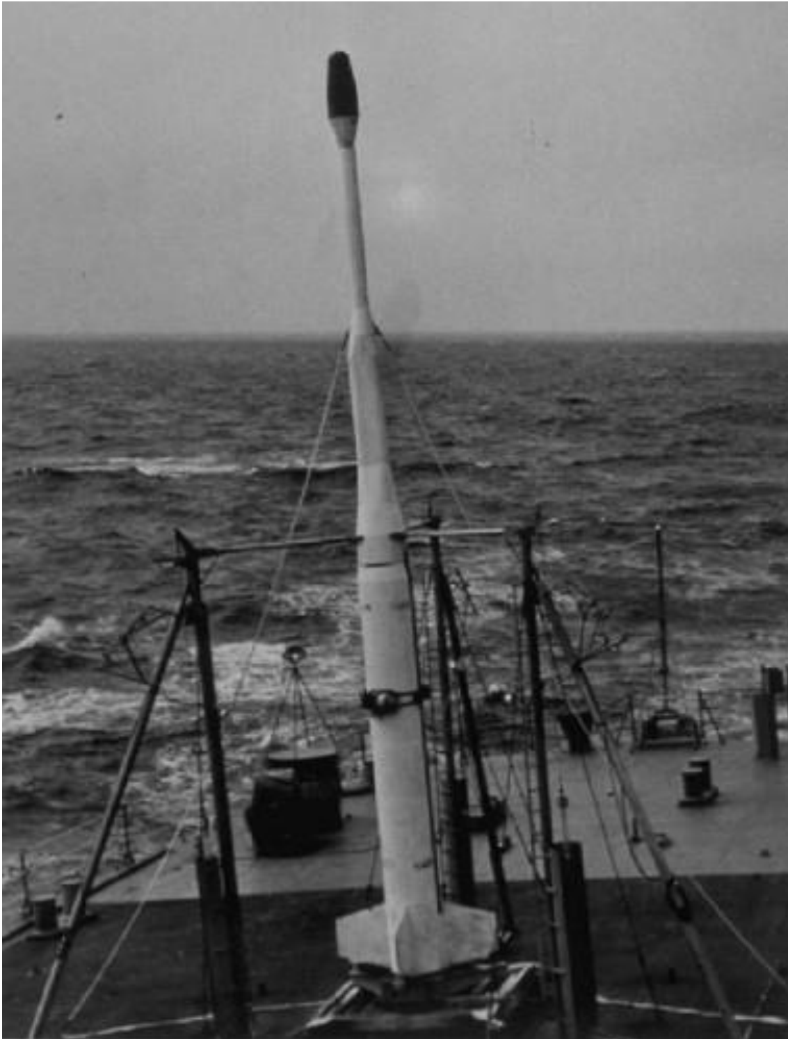
Figura 27 – Míssil X-17 Lockheed com ogiva acoplada em sua ponta a bordo do navio USS Norton Sound , plataforma de lançamento dos mísseis da Operação Argus.
