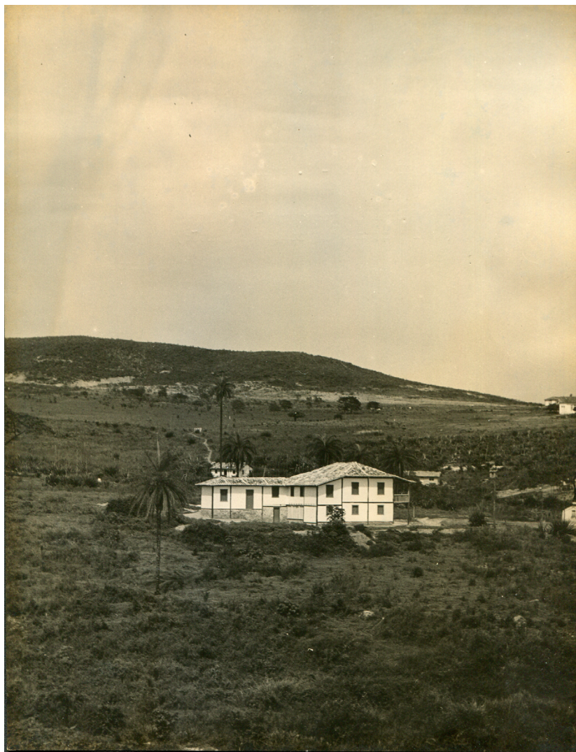
Figura 2 – Sede da antiga Fazenda Velha do Leitão após restauração, 1942. Fonte: MG 005 01 01 INT (Pasta 1/Env.01), Documento n.º F027749, Arquivo Central do IPHAN – Seção Rio de Janeiro.
