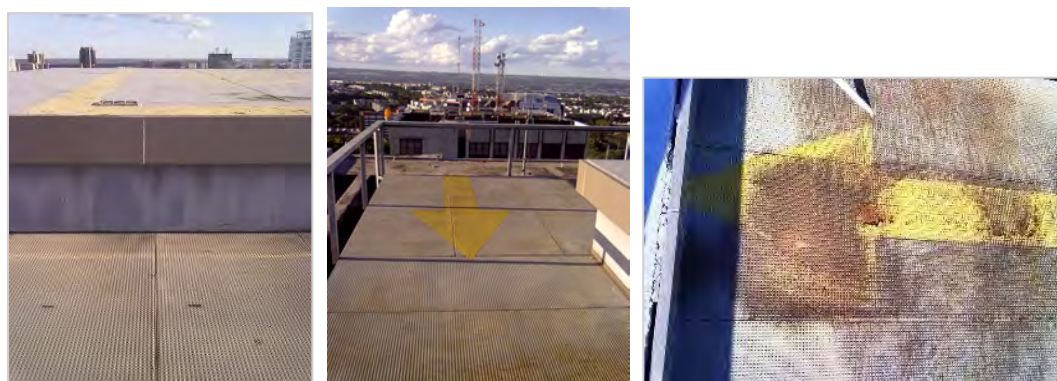
Figuras 7, 8 e 9 – Diferença de altura da FATO para a TLOF e estado precário de manutenção da FATO
