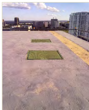
Figura 10 – Alçapões das caixas d’água
