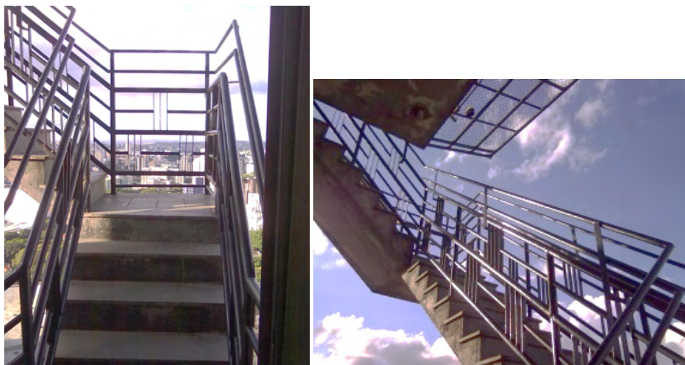
Figuras 14 e 15 – Guarda-corpo e corrimão da escada que liga o último andar tipo da edificação à PDC com altura aumentada.
