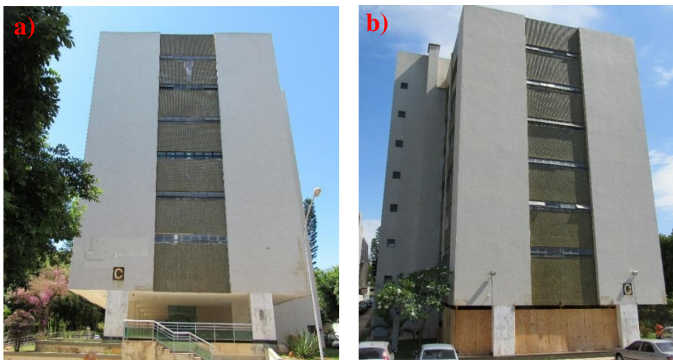
Figura 18 - Fachadas do edifício E1 (a) Norte (b) Sul (c) Leste e (d) Oeste (Fonte: Aidar, 2019)
