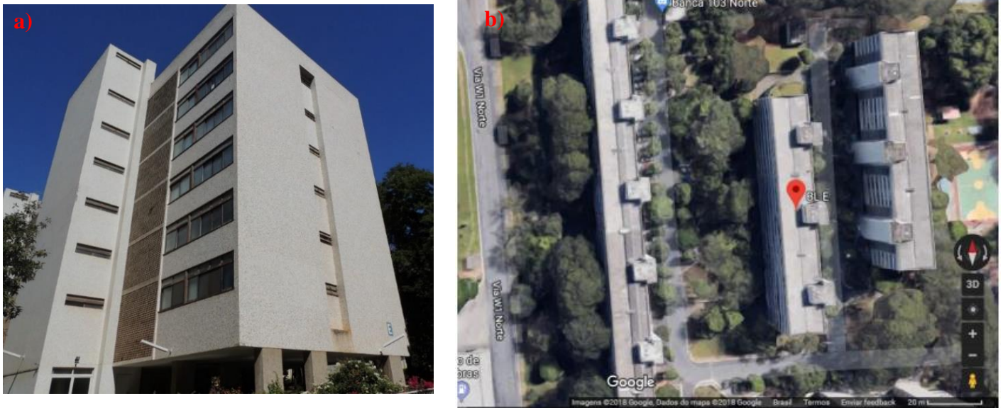
Figura 20 - Edifício E2 (a) imagem digital (b) localização e orientações cardeais das fachadas (Fonte: AIDAR, 2019)
