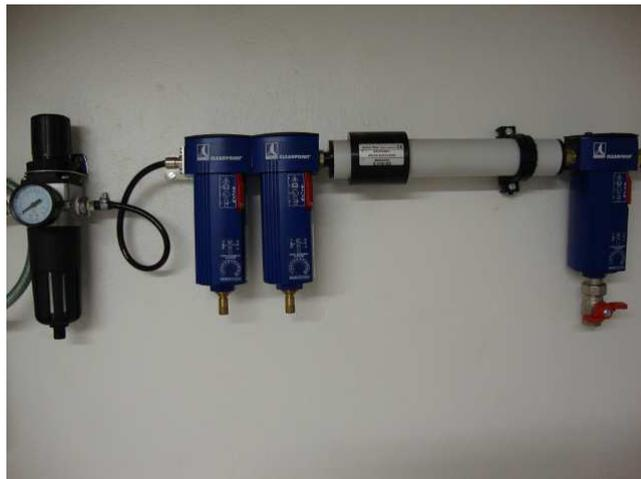
Figura 6.3 – Sistema de filtros de aceite (los dos filtros de la izquierda), deshumidificador (brazo blanco horizontal central) y filtro de partículas (filtro mas a la derecha).
