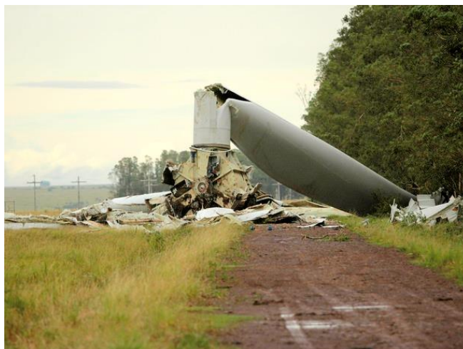
Figura 1.1 – Colapso da torre de aerogerador (RS). Fonte: G1 RS (2014).
