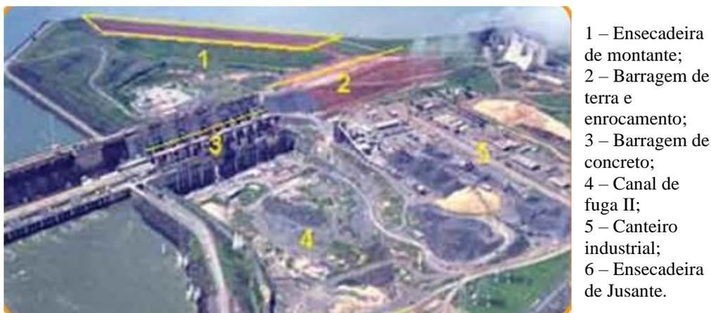
Figura 3.10 – Barragem de Tucuruí (Fonte: GAMA et al, 2006).
