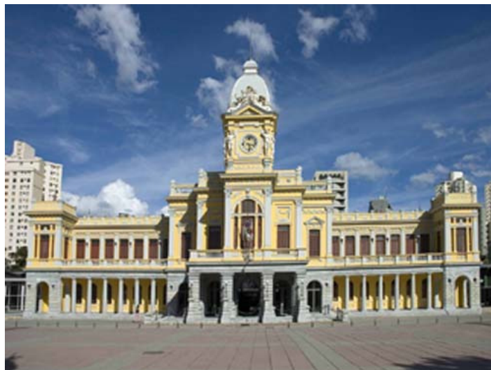
Figura 47: Prédio da antiga Estação Ferroviária após restauração, que o adequou para a instalação do Museu de Artes e Ofícios. Foto: Miguel Aun – acervo do Museu de Artes e Ofícios.
