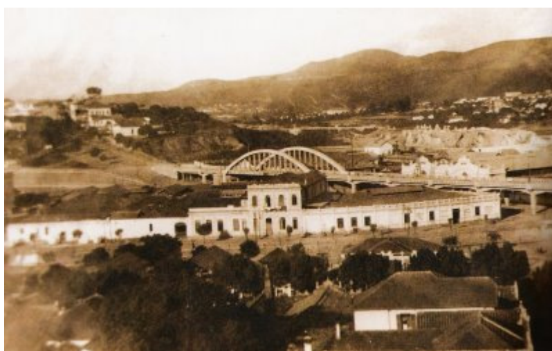
Figura 20: Viaduto de Santa Tereza, vendo-se ao fundo a Serraria Souza Pinto. Foto: disponível no site: http://bhnostalgia.blogspot.com/2008/10/viaduto-santa-tereza-ponte-melo-viana.html
