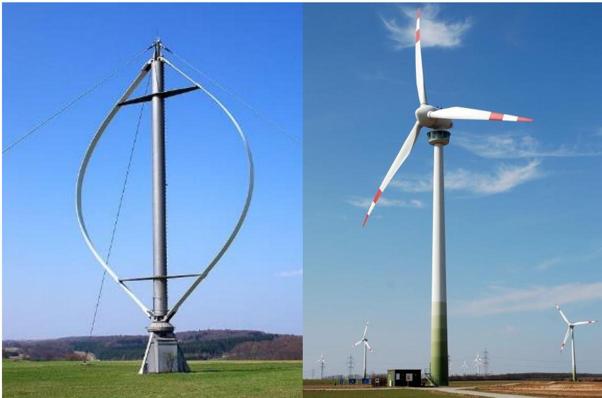
Figura 2.4 Aero geradores de eixo (a) vertical e (b) horizontal (Desconhecido, 2017).
